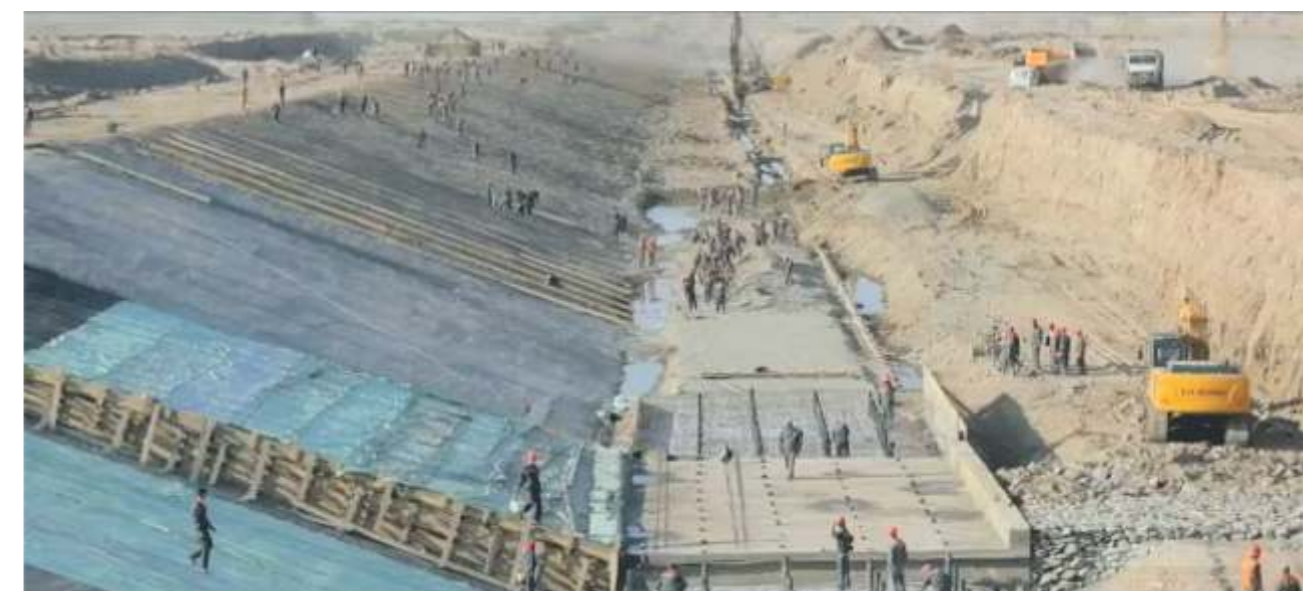
Строительство водосливного сооружения от озера Майпост в русло реки Амударьи
