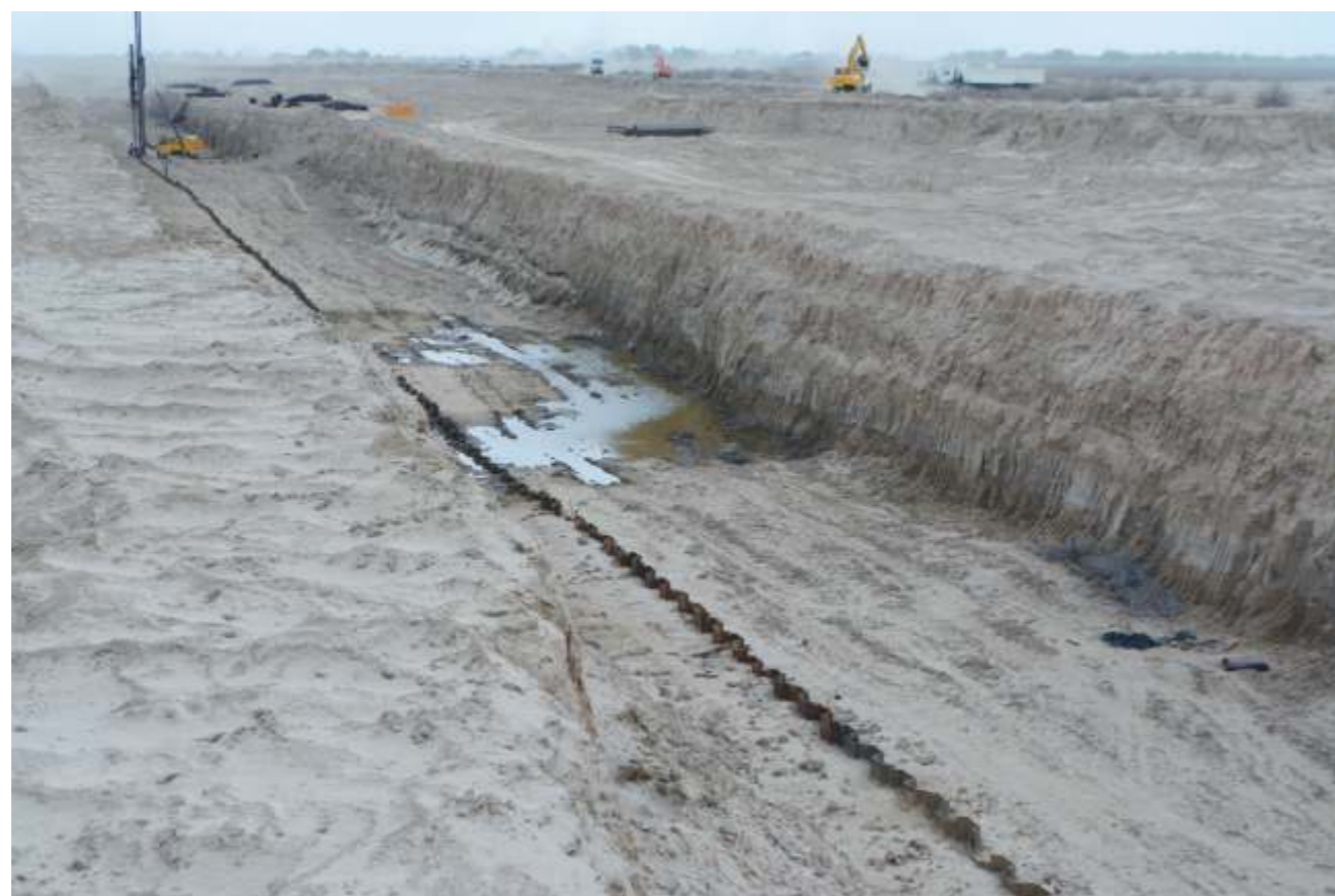
Водослив. Забивка шпунтов в основание
