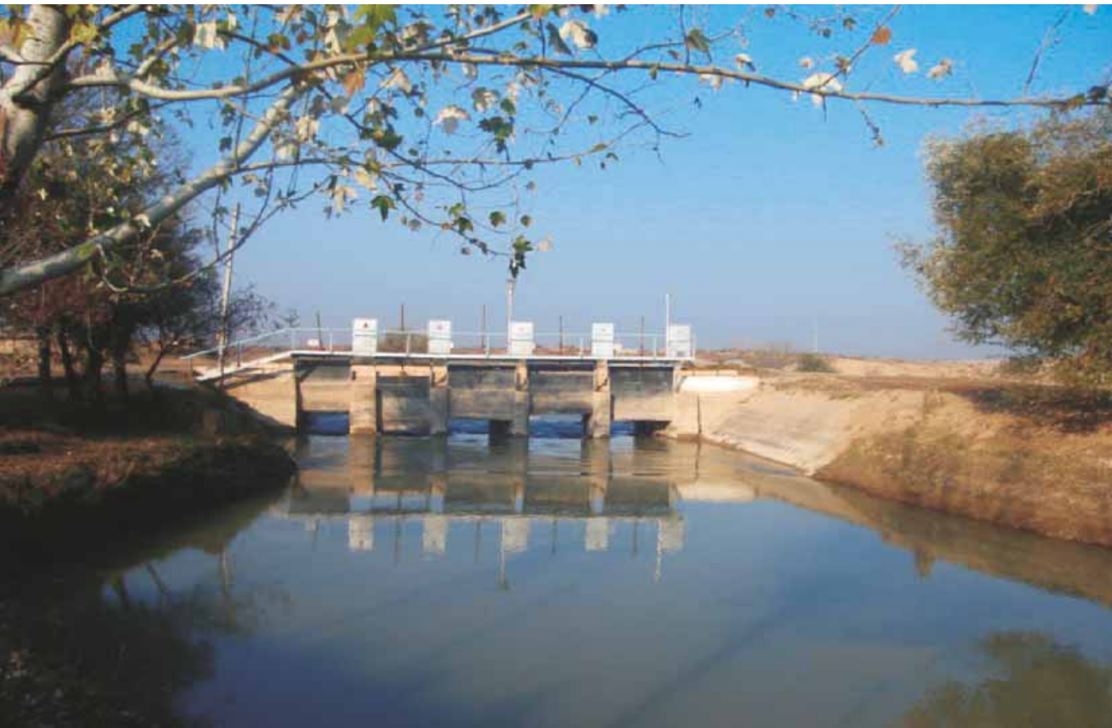
Головное сооружение на канале Обихаёт The headworks on the Obikhaet Canal
