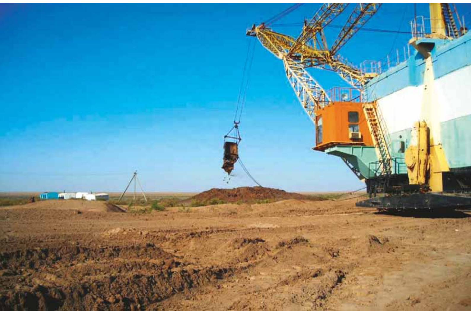
Работа шагающего экскаватора на строительстве Южного коллектора The walking excavator in operation at the construction site of the South Karakalpakstan Main Collector-Drain
