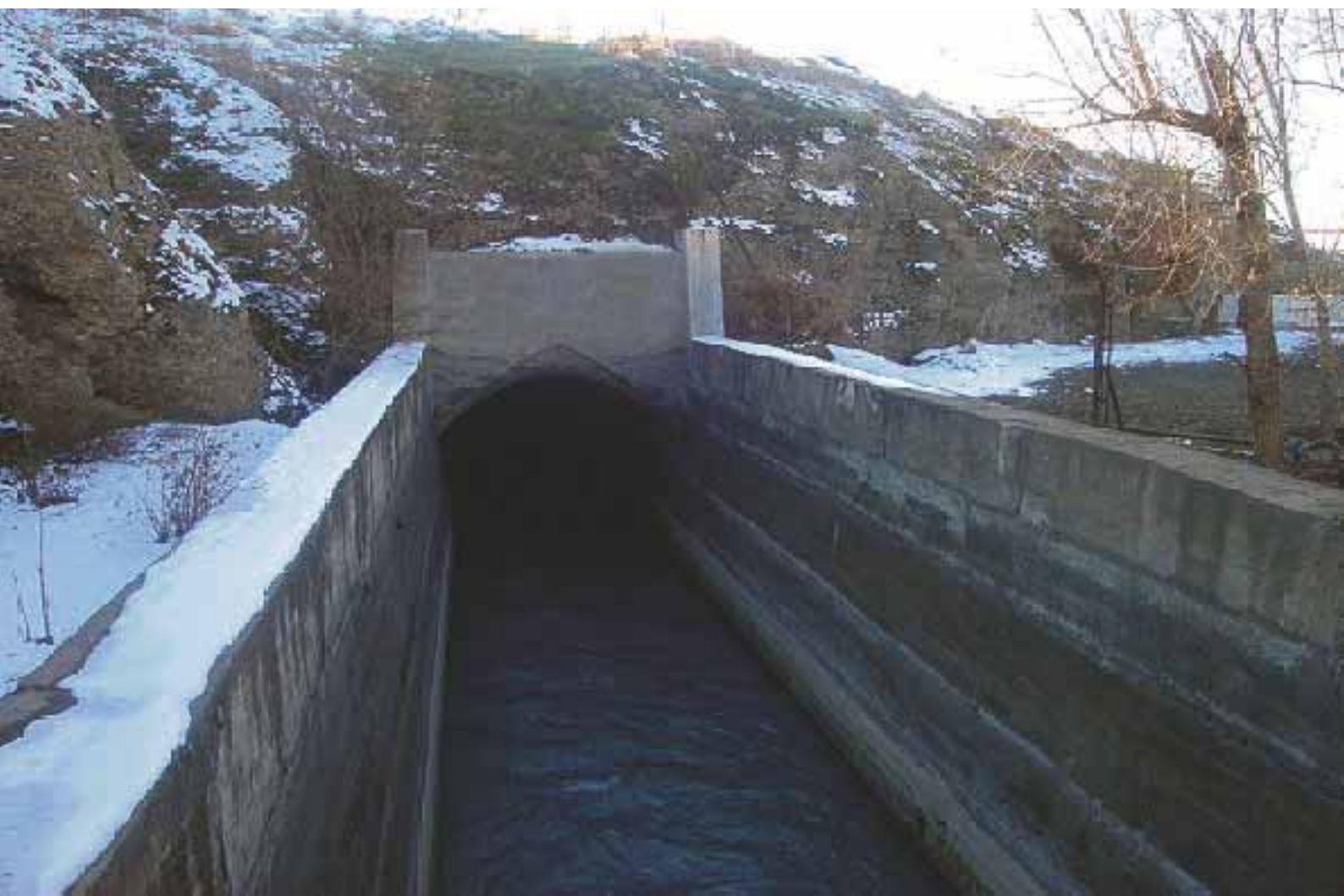
▼ Канал Даргом - туннель на гидроузле Раватходжа длиной 540 м. Построен в 1930 году The Dargom Canal – the tunnel of the Ravatkhodja Hydroscheme (a length of 540 m; built in 1930)
