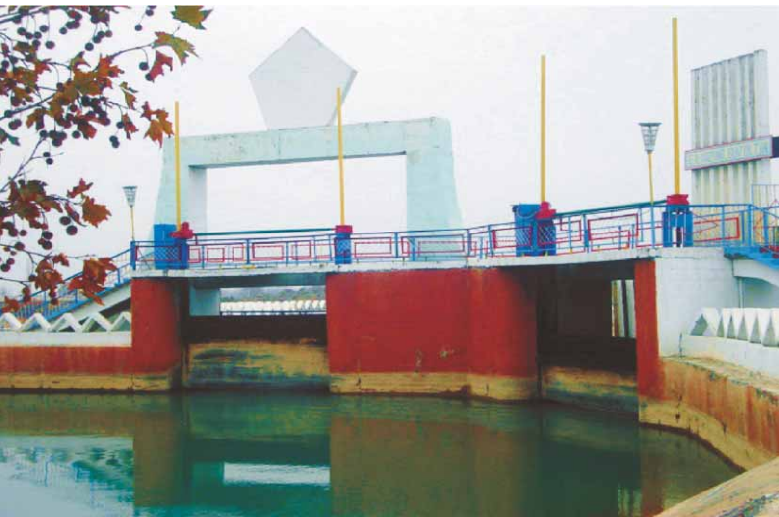
Гидроузел на Большом Андижанском канале Waterworks on the Big Andijan Canal
