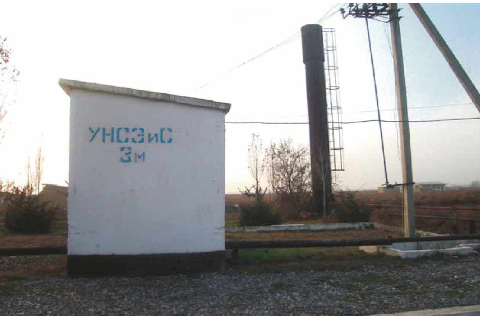
Скважина вертикального дренажа в Голодной степи A pumphouse of tubewell drainage in the Golodnaya Steppe
