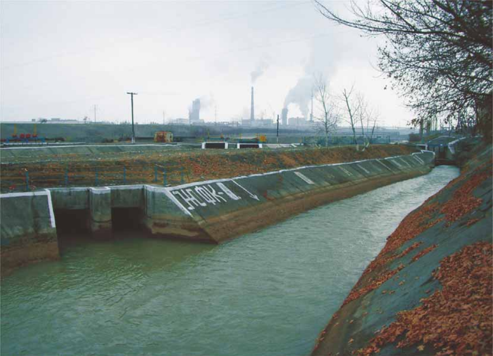
Дюкерный переход на Южно Ферганский канал (г/у «Бешолиш») Pipe subway on South Ferghana canal (Besholish)
