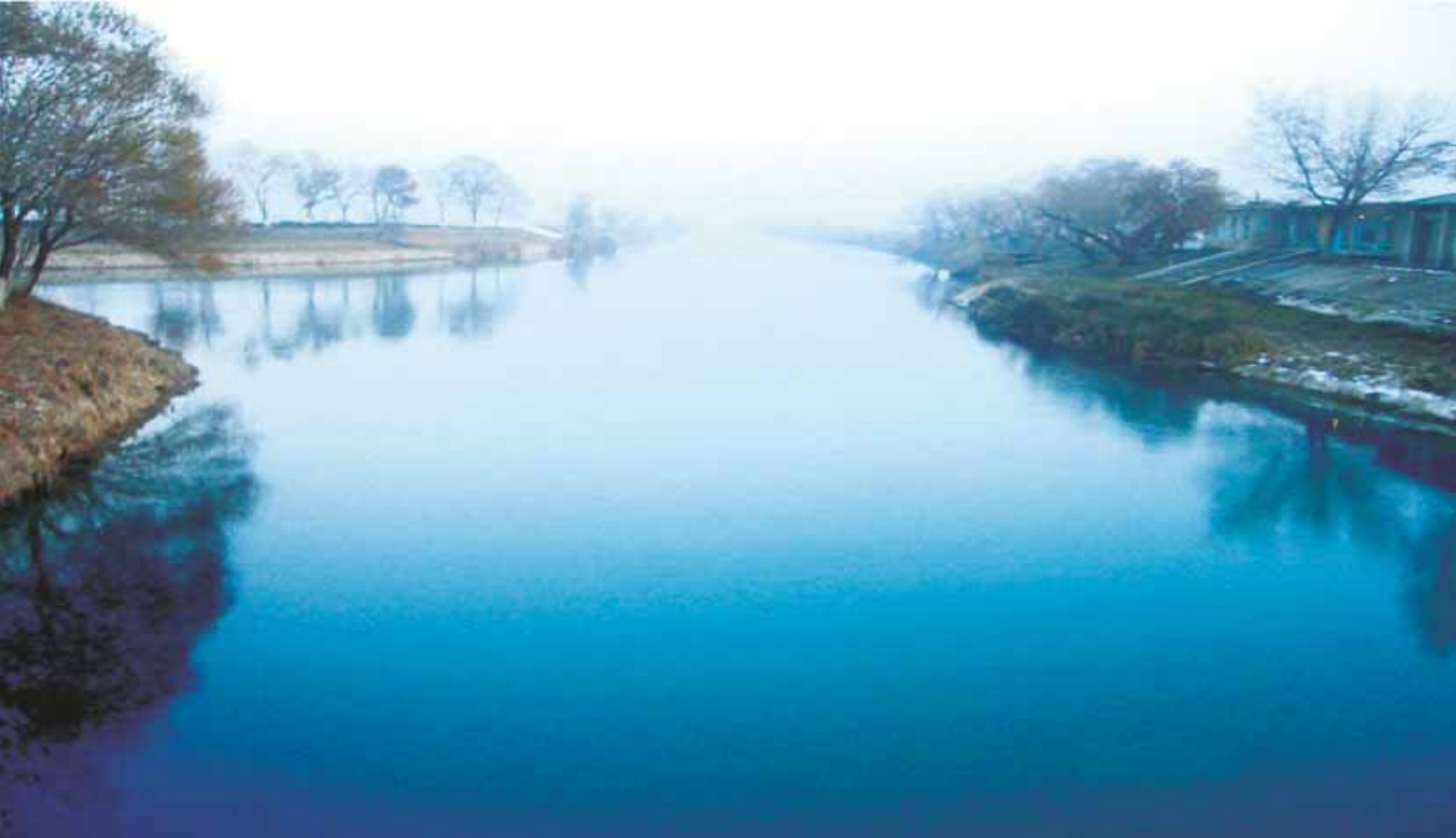
Южно-Голодностепский канал The South Golodnaya Steppe Canal
