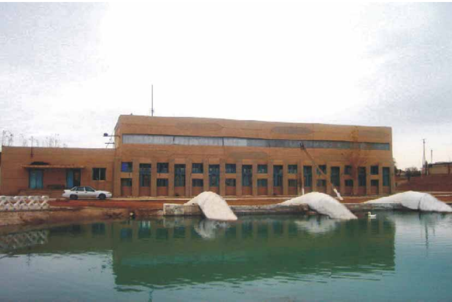
Насосная станция Канимех-2 The Kanimekh-II Pump Station
