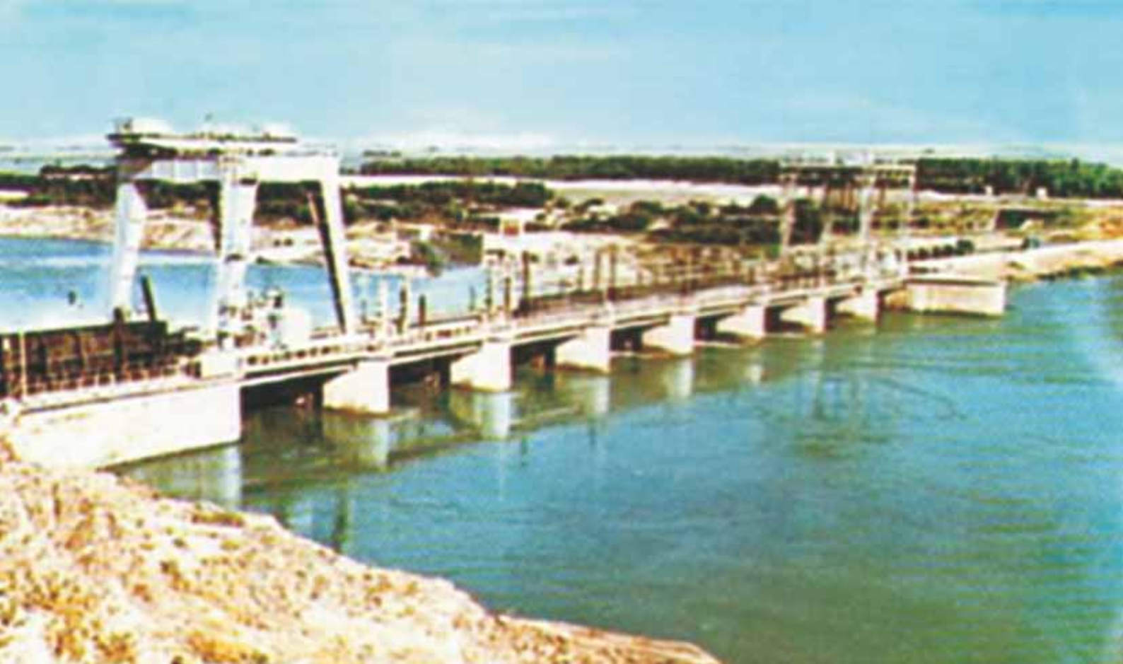
Фархадский гидроузел на реке Сырдарья (1960) The Farkhad Hydroscheme on the Syr Darya River
