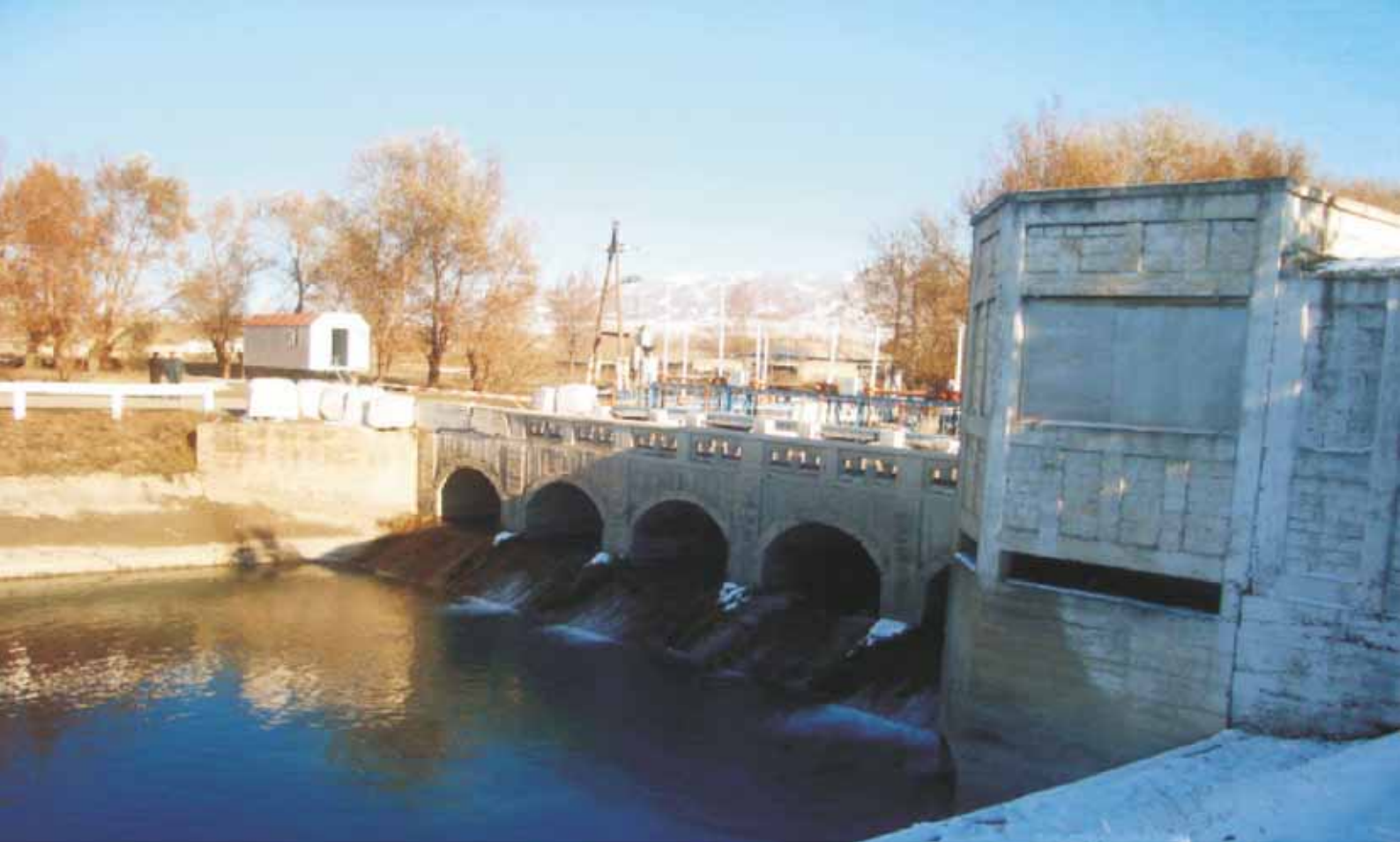
Мост – вододельитель на реке Зеравшан (Правобережный канал) The bridge-divider on the Zeravshan River (the Right-Bank Canal)
