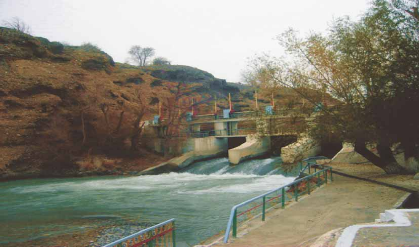
Головное сооружение на Правобережном канале БАК The headwork of the Right-Bank Canal from Great Andijan canal
