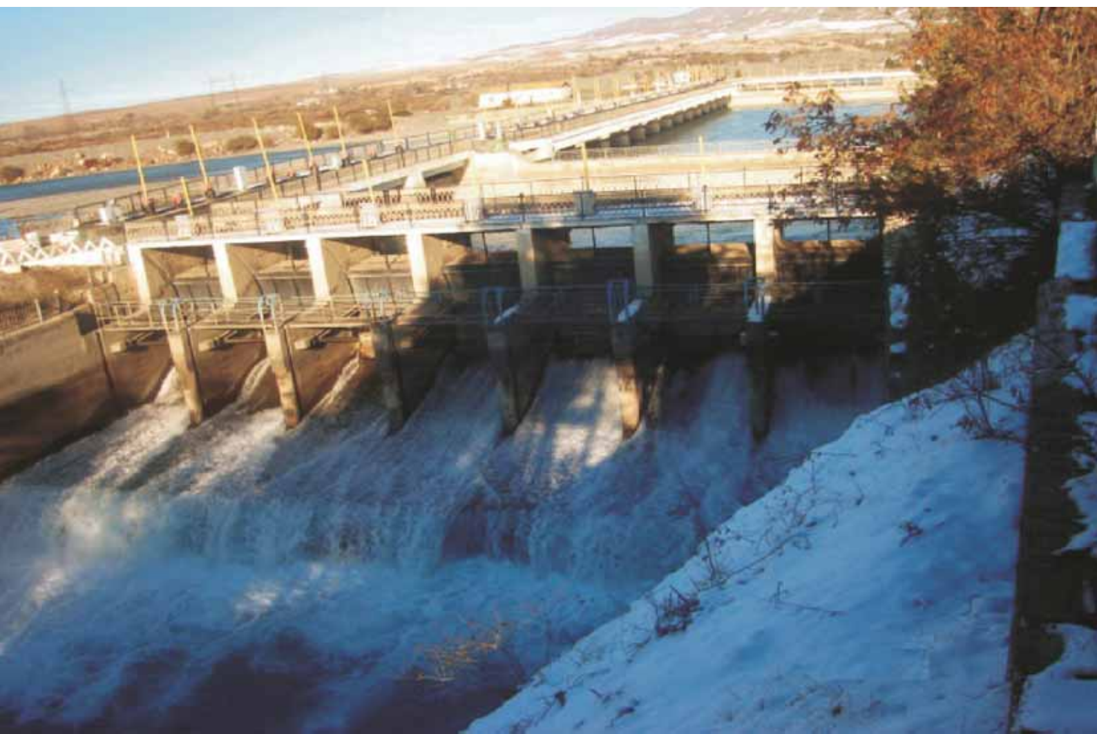
Раватходжинский гидроузел на реке Зеравшан The Ravatkhodja Hydroscheme on the Zeravshan River
