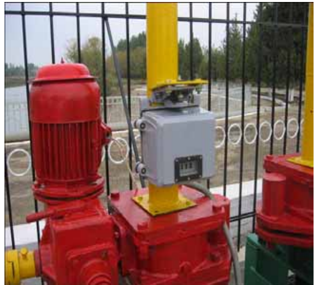
Рис. 6. Установка ДПЗ на винт затвора
