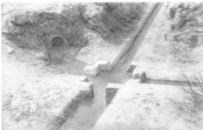
Чтобы использовать подземные воды сухих долин, спускающихся с гор, приходится устраивать водосборные галереи (кяризы). Вода из них по бетонированным галереям распределяется по полям для орошения.
