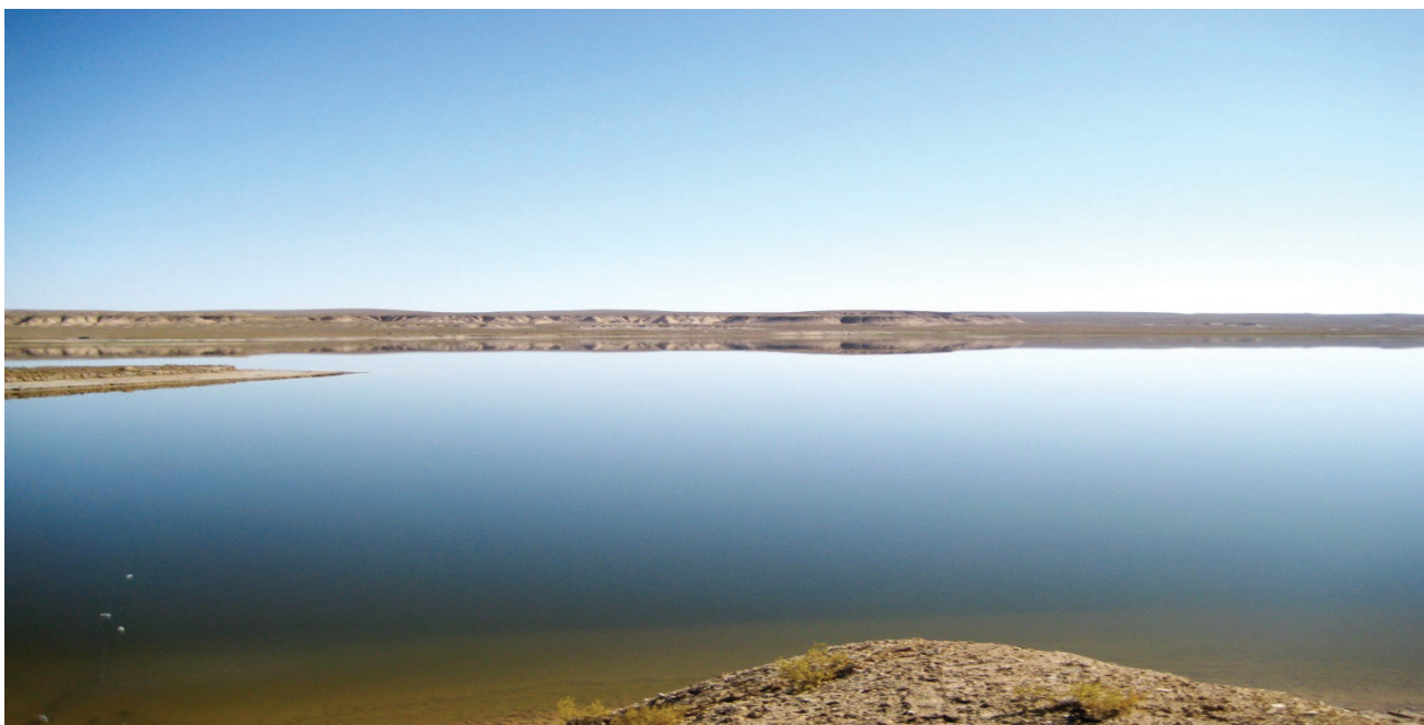
Рис. 1. Главный накопительный коллектор
