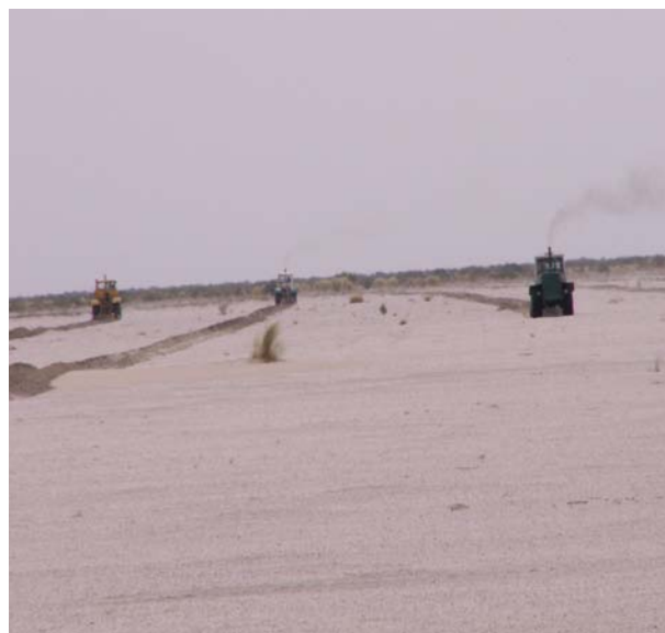
Рис. 2. Устройство песконакопительных борозд
