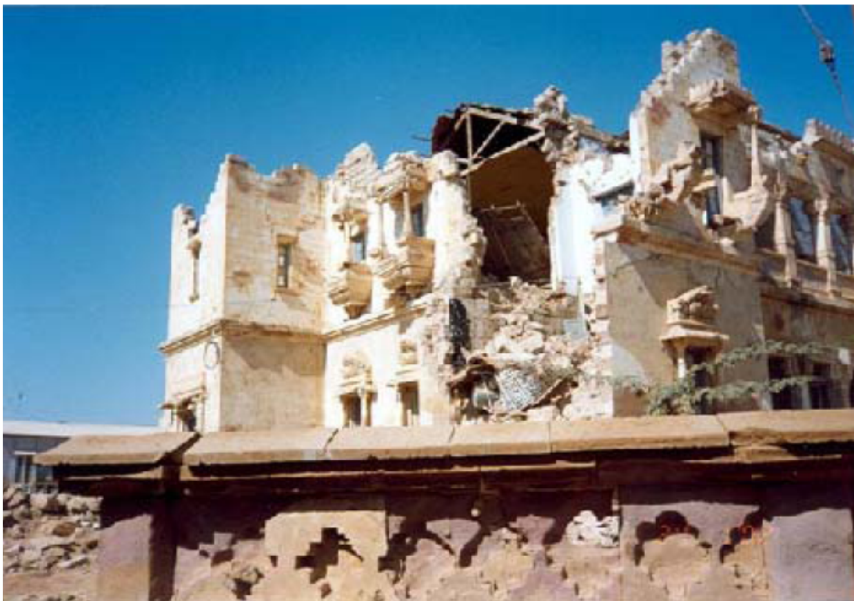
Рис. 4.3.1 Разрушение здания в районе городской застройки во время землетрясения в Бхуй (Индия) 26 января 2001 г. Землетрясение привело к полному разрушению всех основных коммуникаций, включая систему водоснабжения
