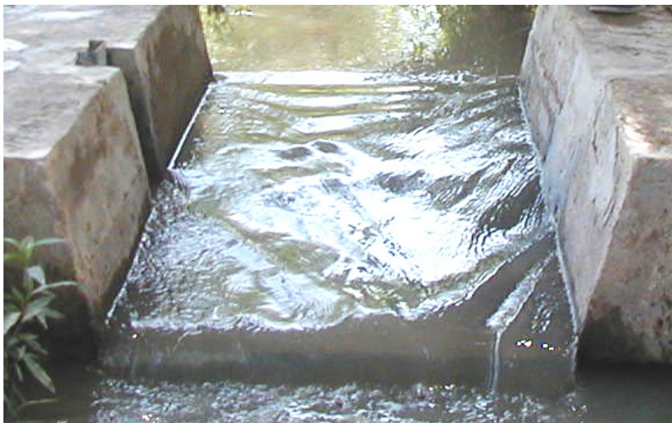
Гидропост «Фиксированное русло» с уровнемерной рейкой в нише.
