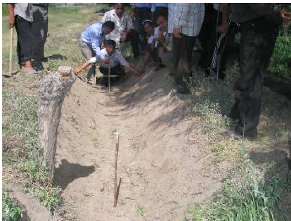
Разбивка створа гидропоста
