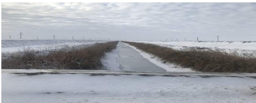
Рисунок 1 – Участок оросительного канала Сарпинской обводнительно-оросительной системы (автор фото В. Ф. Талалаева) Figure 1 – Irrigation canal section of the Sarpinsky irrigation system (photo by V. F. Talalaeva)
