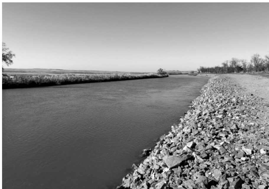
Рисунок 1 – Общий вид реконструированного участка Невинномысского канала (автор фото О. А. Баев)
