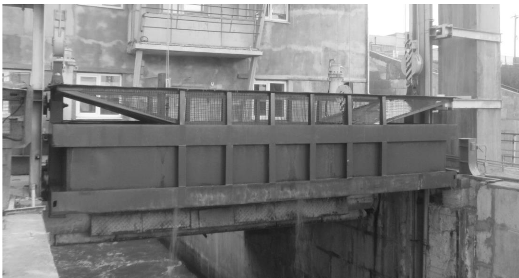
Рисунок 1 – Живорыбный контейнер для сбора, перемещения и выпуска рыб, используемый на Краснодарском рыбоподъемнике (автор фото В. В. Ванжа)
