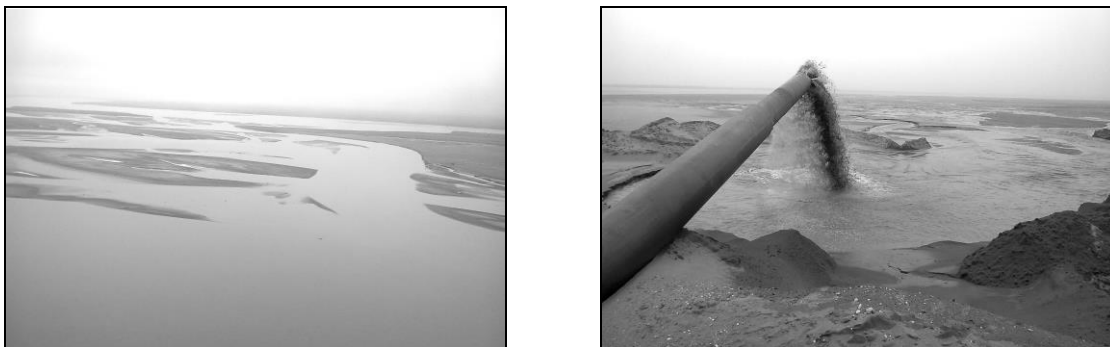
Рисунок 1 – Водозабор и очистка головной части Каршинского магистрального канала (автор фото НИИИВП)
