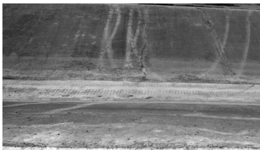
а – бетонная облицовка до проведения ремонта; б – геомембрана, уложенная на поверхность облицовки
