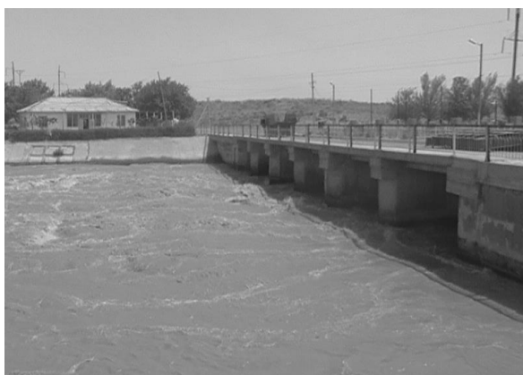
Рисунок 1 – Состояние потока в водоподводящих сооружениях крупных НС (фото НИИИВП)
