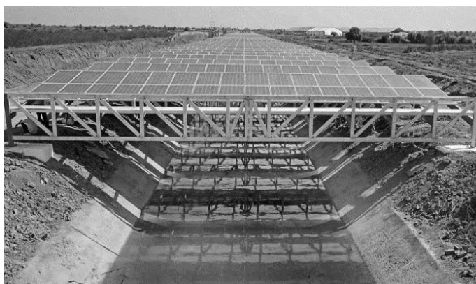
Рисунок 5 – Реализация проекта Canal Solar Power Project (Индия) [12]
