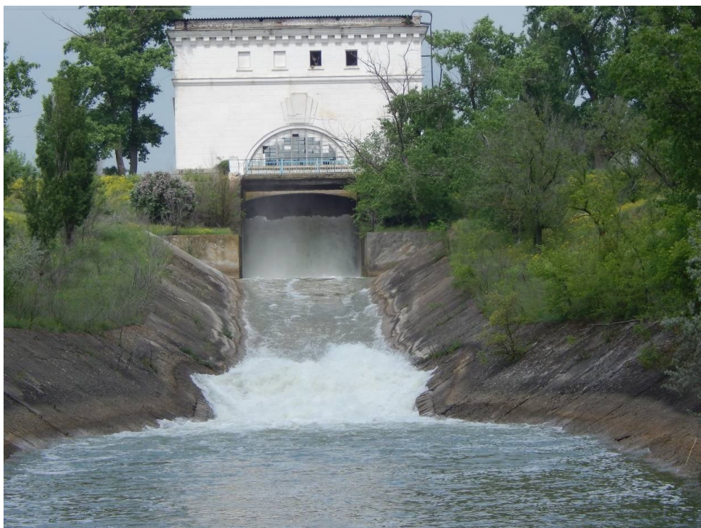
Рисунок 1 – Головное сооружение Садковского сброса (автор фото А. В. Акопян)
