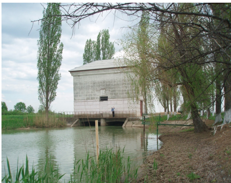
Рисунок 2 – Водозаборное сооружение на Пролетарском магистральном канале (автор фото Е. И. Шкуланов)
