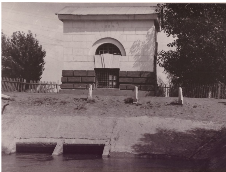
Рисунок 1 – Здание управления затворами головного водозаборного сооружения Садковского канала (источник – технический паспорт сооружения)
