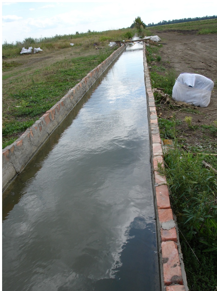
Рисунок 2 – Стенка лотка, наращенная керамическим кирпичом
