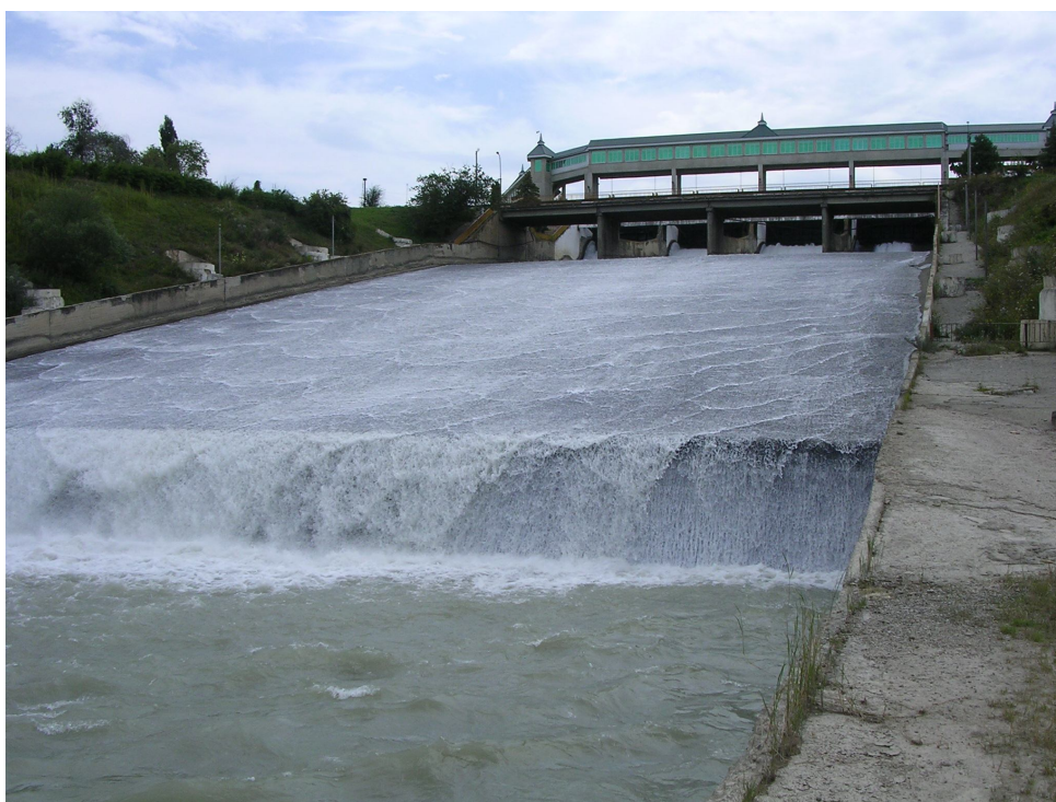
Рисунок 2 – Водосброс Усть-Джегутинского гидроузла, вид с НБ
