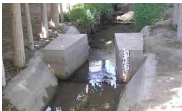
б) Гидропост с лотком САНИИРИ
