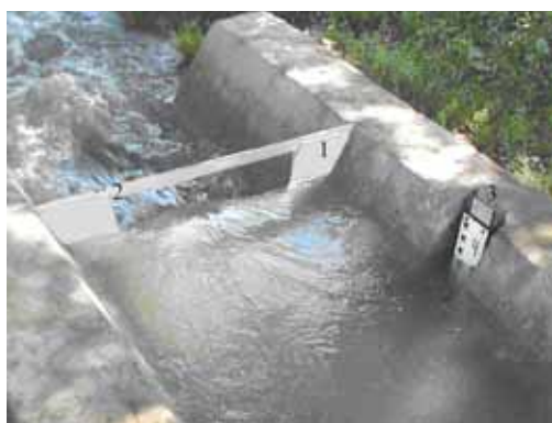
а) Гидропост с водосливом Чиполетти
