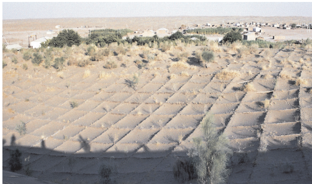
Рис.2. Закрепление подвижных песков механическим способом
