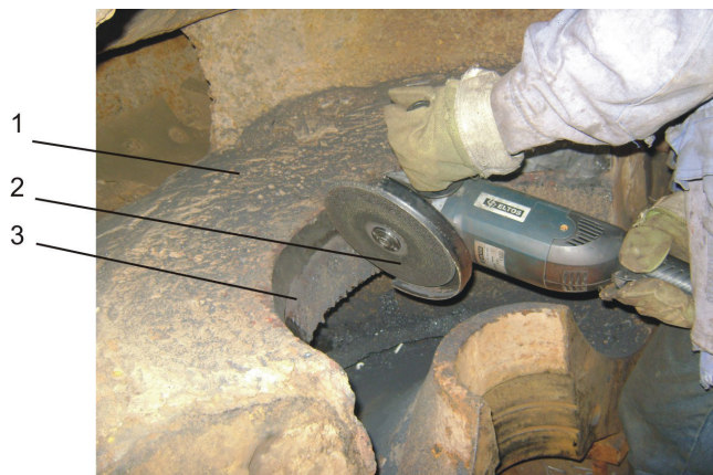
1-насос корпуси; 2-механик ишлов бериш воситаси; 3-зичловчи ҳалқа ўрнатилиш жойи
