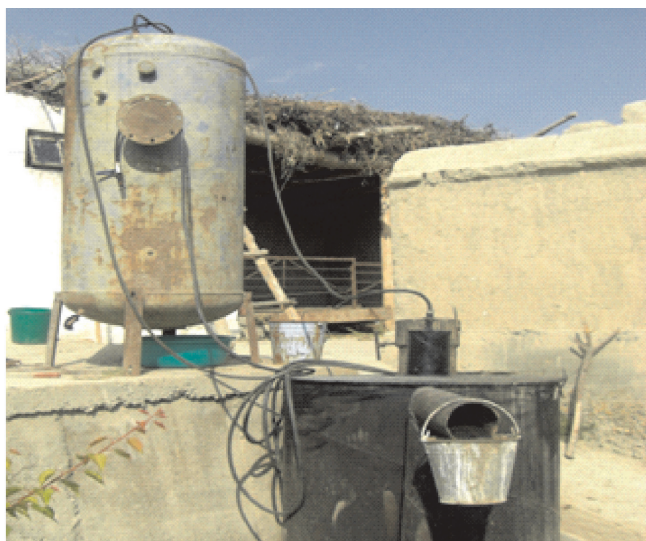
Рис.1.Пилотная биогазовая установка (объем 1200л)
