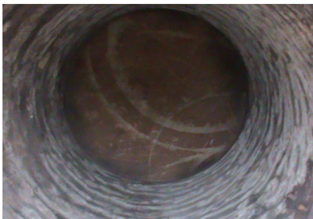
1-расм. Ички юзаси тозаланиб торкретлаш учун тайёрланган диаметри 1420 мм бўлган қувур
