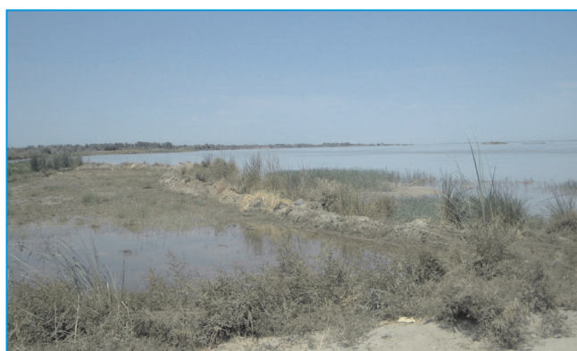
Рис.1. Заиление и освоение междамбного пространства на реке Амударья (между дамбами 33 и 35)
