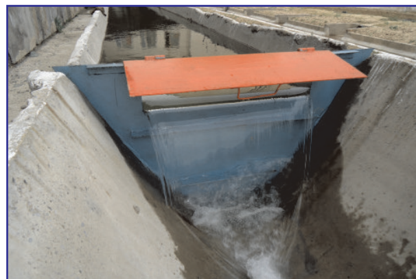
7-расм. Лоток тармоғида сувни параболик ясси дарвозалар билан бошқариш
