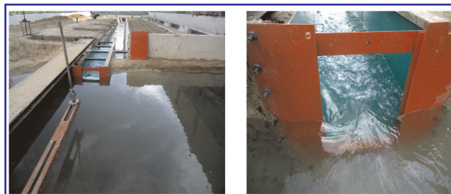
9-расм. Ясси дарвозали очiq сув чиқаргич фои қуйидаги формула ёрдамида ҳисобланади
