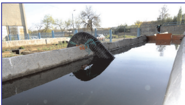
6-расм. Лоток тармоғидан сифон ёрдамида сув олиш
