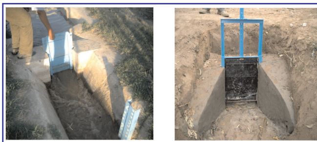
2-расм. Шандор типли ва винтсиз ясси дарвозали сув чиқаргичлар
