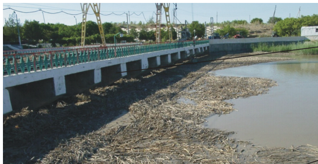
4 - расм. Хамза-2 насос станциясида оқизикларни тутиб қолувчи панжара олдида тўпланиши
