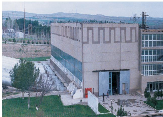
Рис 1. Насосная станция «Аму-Занг-2» в Сурхандарьинской области
