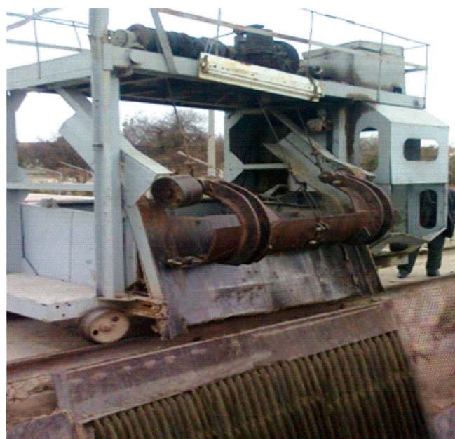
3-расм. Хамза - 2 насос станциясидаги панжараларни тозалаш машинаси
