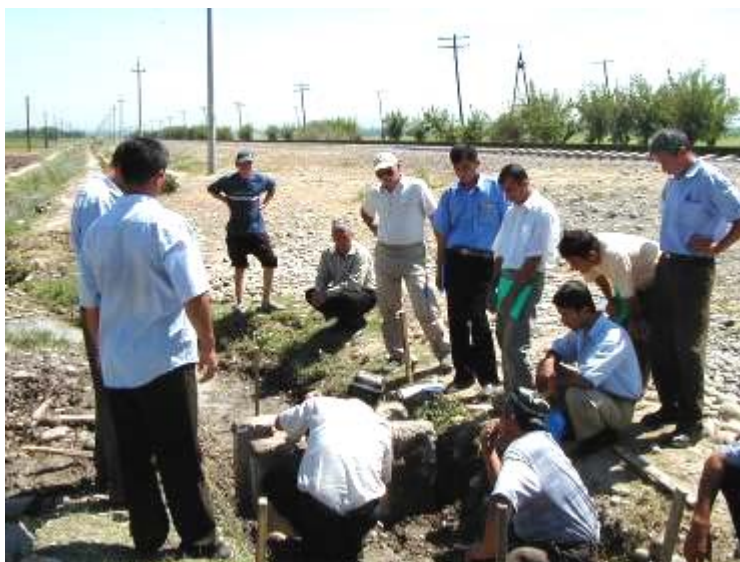
Рис. 5. Установка «ВЛС» заводского изготовления в створе гидропоста
