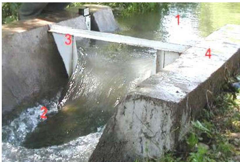
Рис.2. Водослив Чиполетти (вид с нижнего бьефа):
