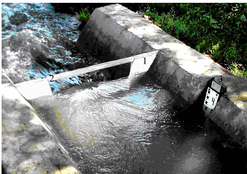
Рис. 1. Водослив Чиполетти (вид с верхнего бьефа): 1- водослив ВЧ-50; 2-ребро жесткости; 3-успокоительная ниша с уровнерной рейкой.
