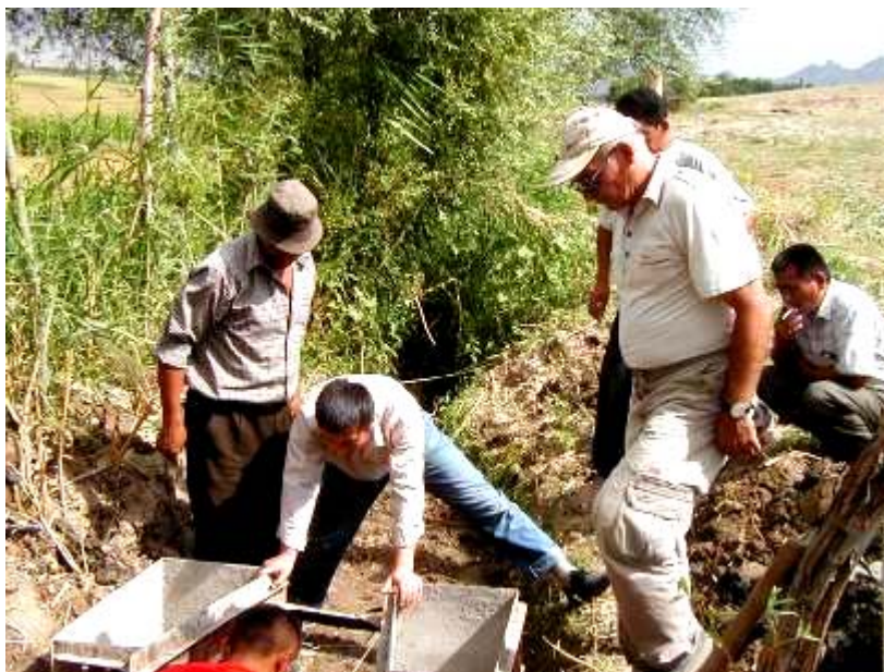
Рис.6. Установка металлической опалубки для отливки лотка САНИИРИ
