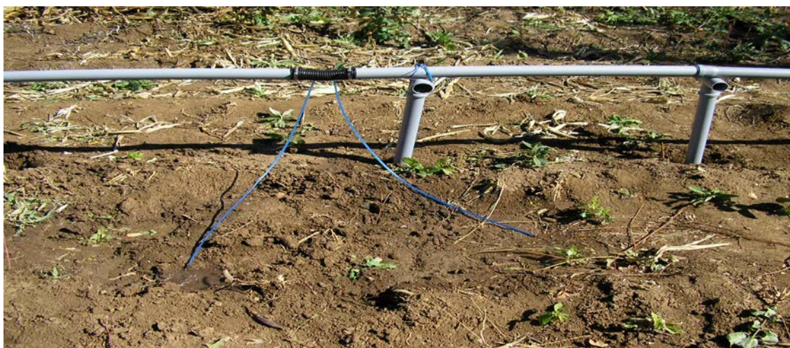
Рисунок - Участок низконапорного трубопровода из жестких труб, соединенных гофрированными муфтами
