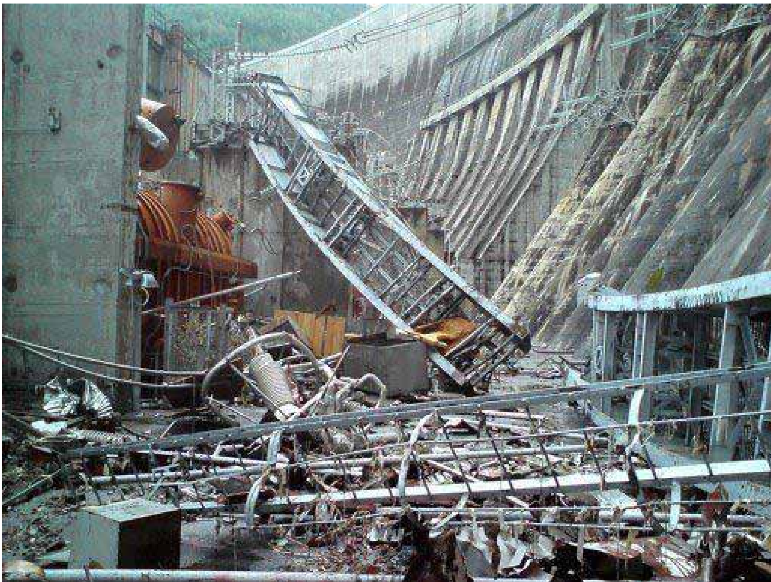
Разрушение машинного зала СШГЭС
