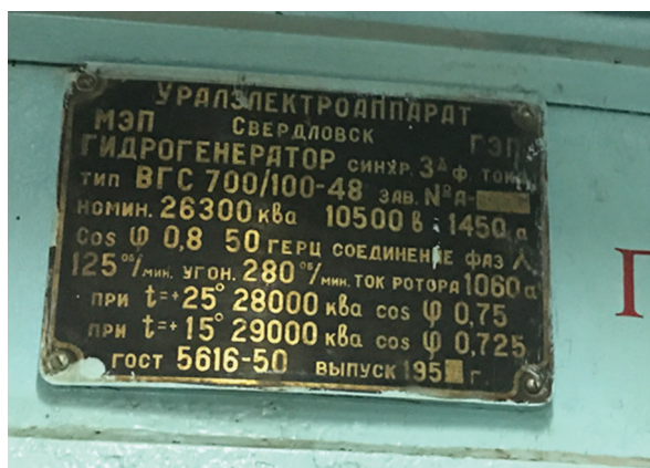
Рис. 3. Генератор Кайраккумской ГЭС 1957 г. выпуска
