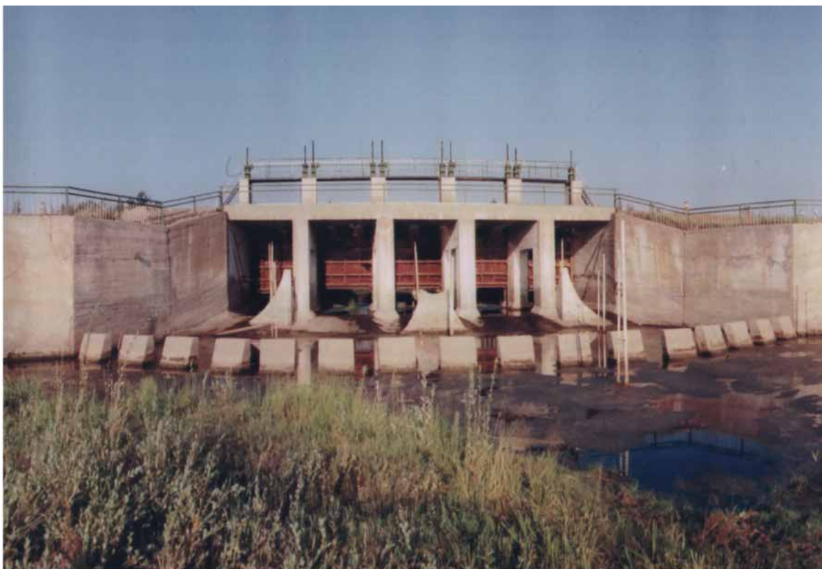
Вид с верхнего бьефа на головной железобетонный водосброс на р. Суола.
