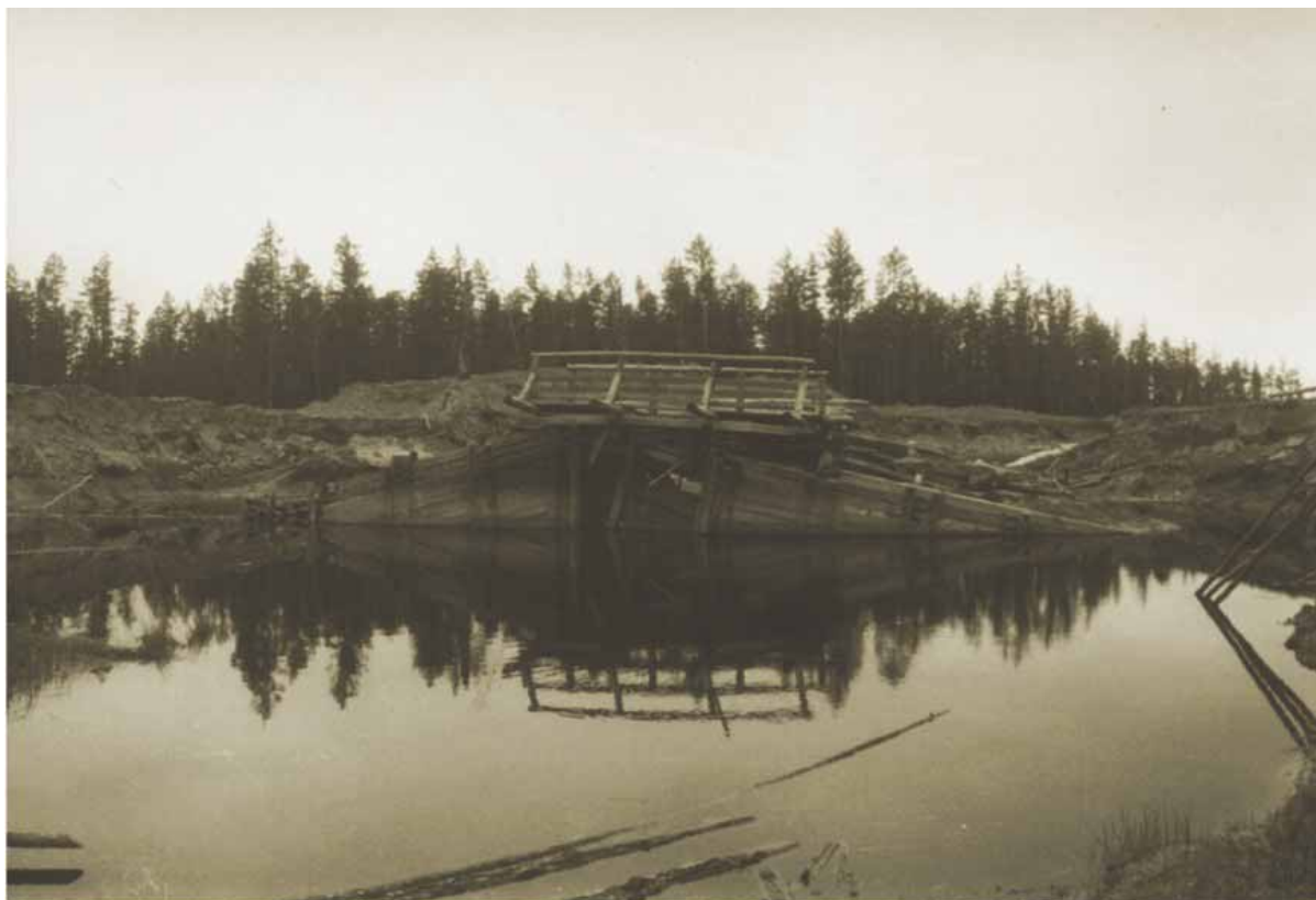
Хоробутская мелиоративная система в Мегино-Кангаласском улусе РС(Я). Деревянный шлюз-регулятор № 4 стоечно-обшивной конструкции, разрушенный паводком в 1971 г.
