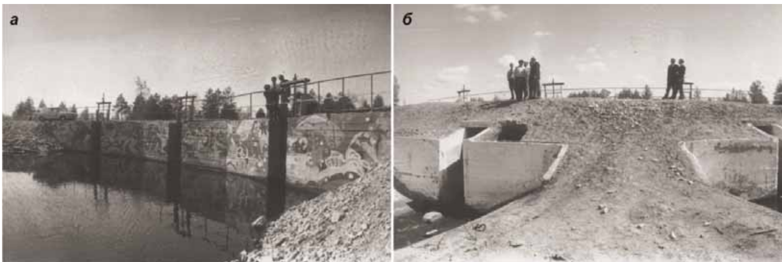
Пригород г. Якутска. Железобетонный шлюз-регулятор на р. Шестаковке: а – вид с верхнего бьефа, б – с нижнего.
