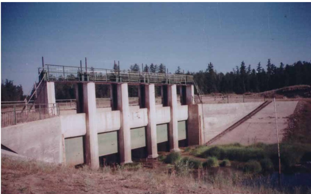
Хоробутская мелиоративная система в Мегино-Кангаласском улусе РС(Я). Головной железобетонный водосброс на р. Суола – вид с верхнего бьефа.
