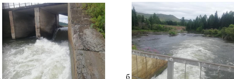
Рисунок 2 – Сбой потока в нижнем бьефе в момент обследования (фото ООО «СГТ»):
