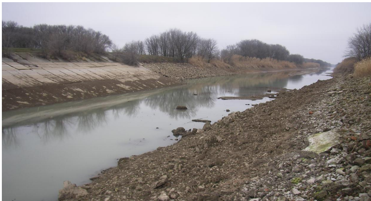
Рисунок 3.17 – Зафиксированный уровень воды в канале при полном опорожнении в створе №1 (дата проведения наблюдений 8.12.12г.)
