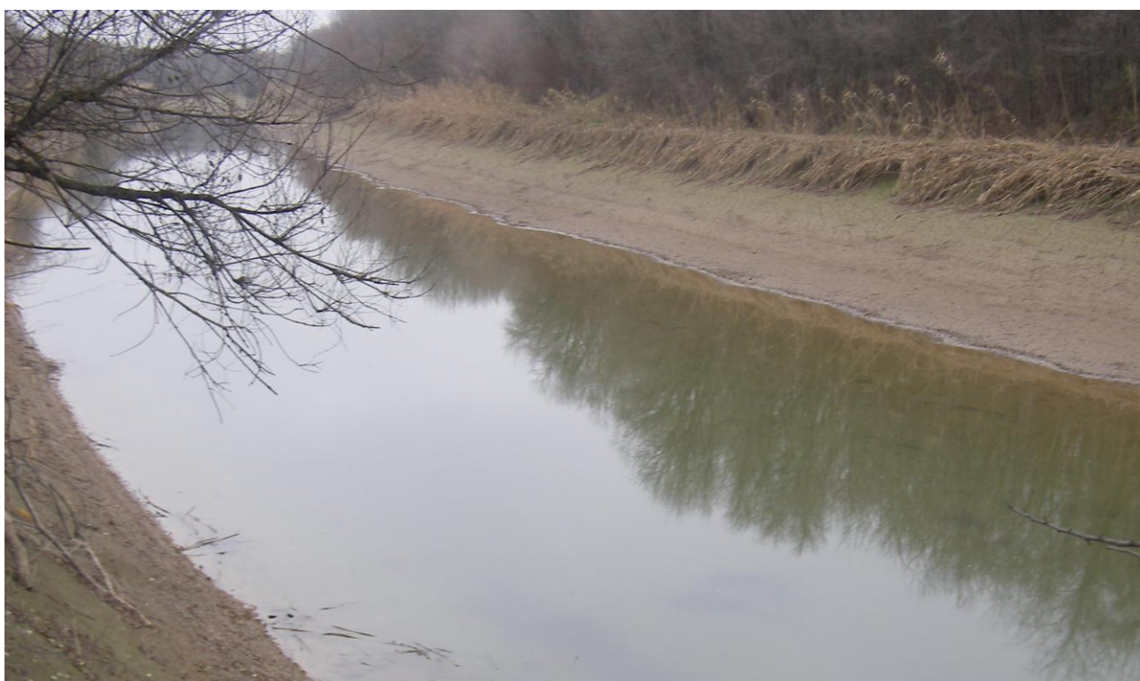
Рисунок 3.19 – В период полного опорожнения канала в этом створе №3 наблюдался уровень стояния грунтовых вод 1,25м (дата проведения наблюдений 8.12.12г.)
