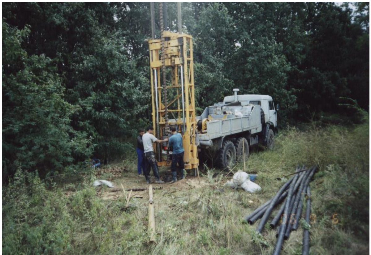
Рисунок 3.15 – Процесс бурения скважины до глубины 6 м путем наращивания шнека
