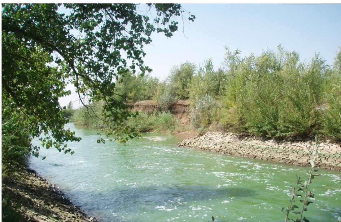
Рисунок 3.11 – Размыв берегов Пролетарского МК
