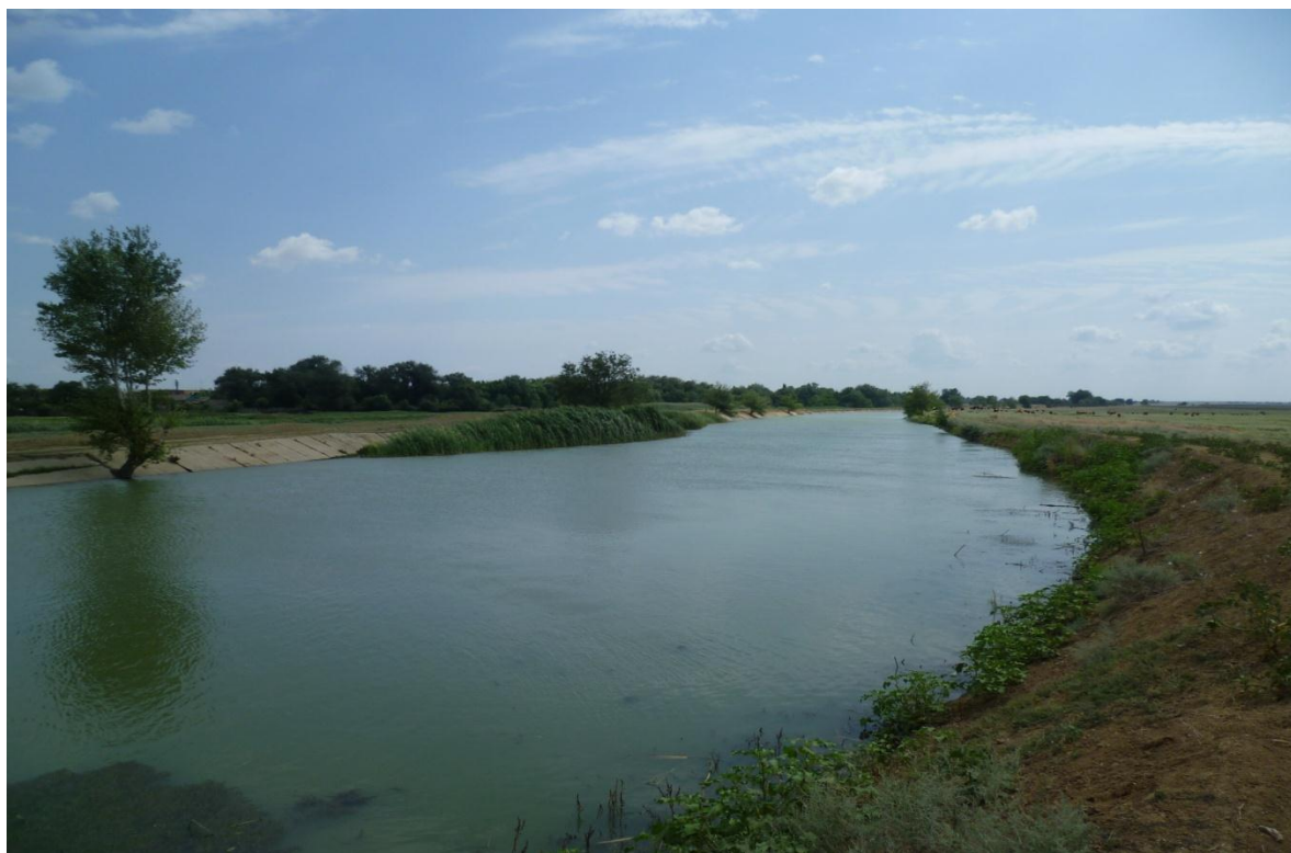
Рисунок 3.4 – Общий вид Пролетарского магистрального канала
