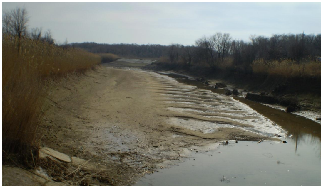
Рисунок 3.7 – Опльвы дамб Донского магистрального канала
