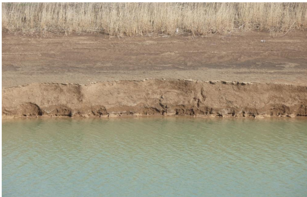
Рисунок 3.8 – Деформации откосов на Донском магистральном канале
