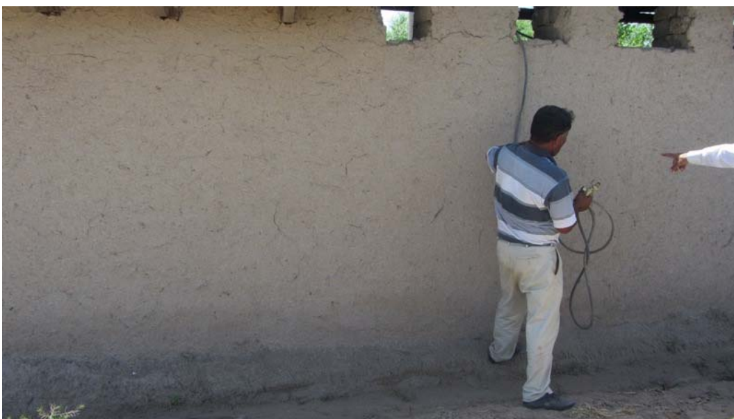
Приобретено оборудование для контроля, распределения биогаза, которые было монтировано соответствующим образом.
