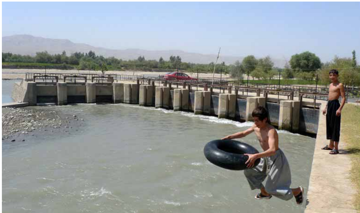
Фото 2: Головное сооружение Шаравана (справа, восемь затворов) и водослив Шарана (слева, три затвора)
