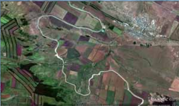
Участок мажоранного канала БСК-4, ПКЭР (район Ежовитинского распределителя)
