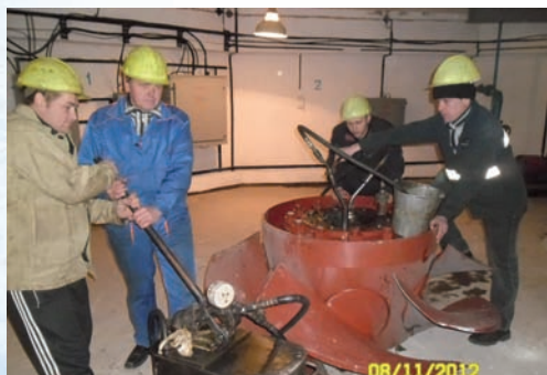
Бригада слесарей ремонтной мастерской Хилько Е.Н., Якушев А.Г., Миряшев А.В., Сущик Д.Н. испытывают рабочее колесо насосного агрегата
