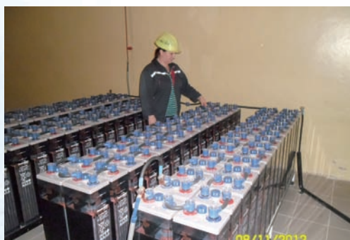
Аккумуляторная батарея оперативного тока. Шарыповова Т.А.
