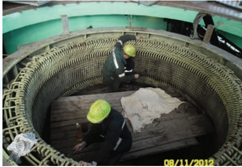
Ремонт двигателя насосного агрегата
