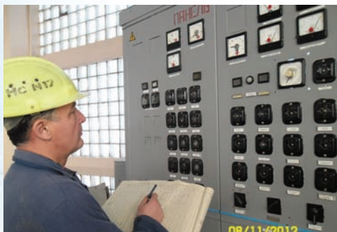
Дежурный оператор насосной станции Пинчук А.И. снимает параметры работы агрегата
