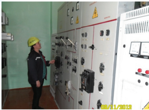
Панель управления оперативным током ОПУ. Аккумуляторщик Шарыпова Т.А.
