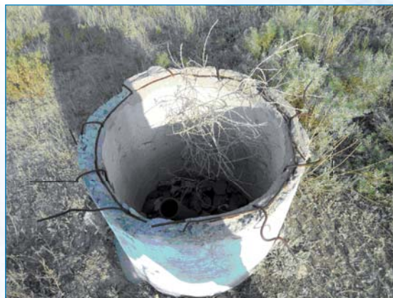
Типовая картина состояния пьезометрических скважин. Слева водохранилище Ащибулак, справа – Акешке.
