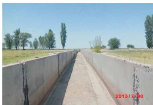
Сбросной канал, подпитывающий западную ветку Большого Чуйского канала
