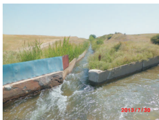
Гидроузел на МК Майлибай
