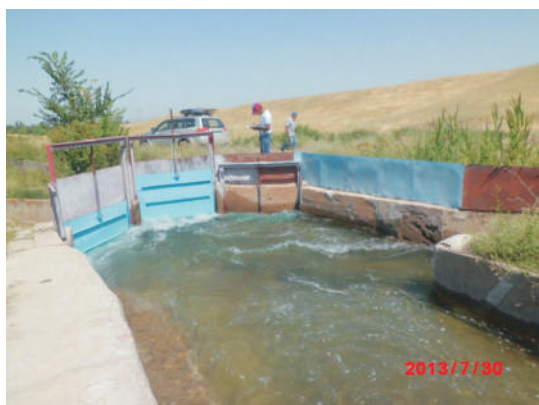
Гидроузел на МК Майлибай
