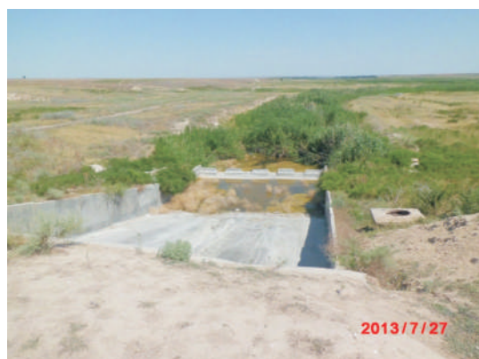
Нижний бьеф автоматического водосбросного тракта Таттинского водохранилища в реку Курагаты
