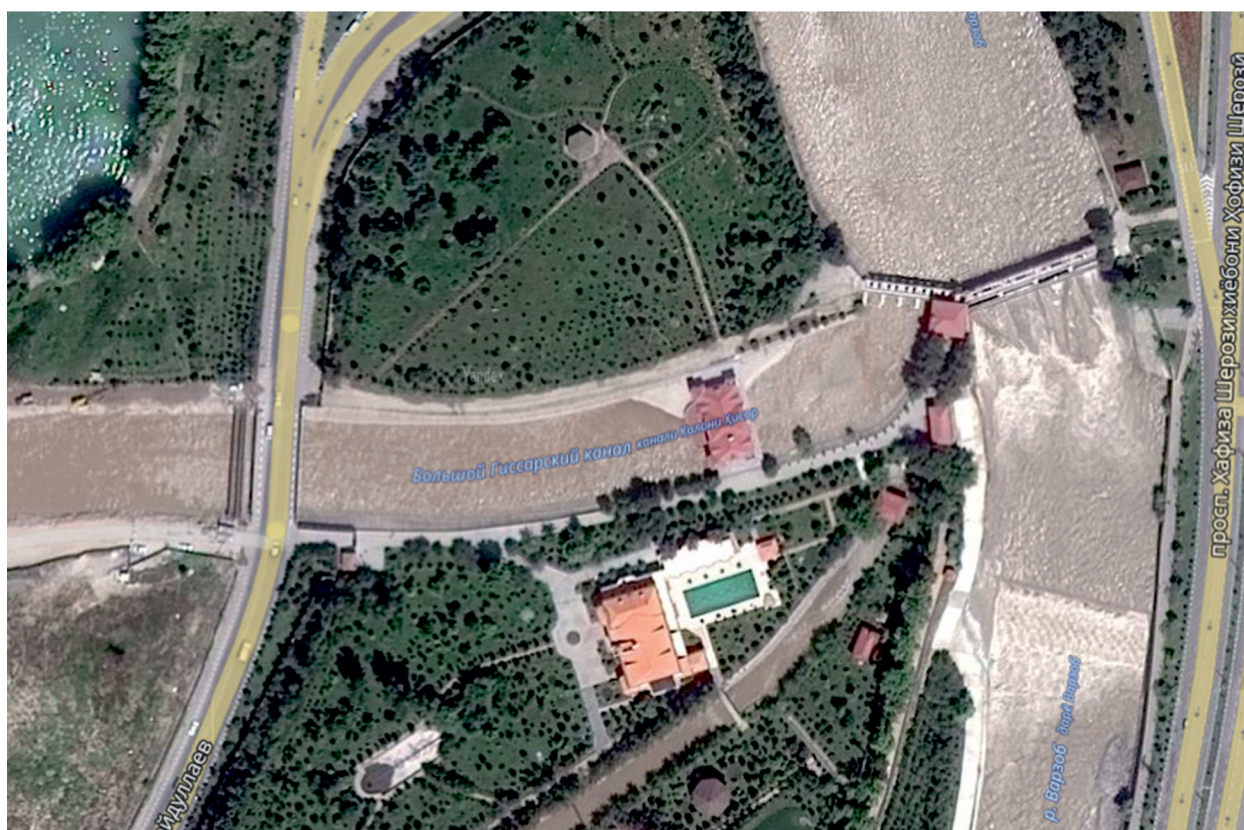
Рис. 1. Водозаборное сооружение БГК
