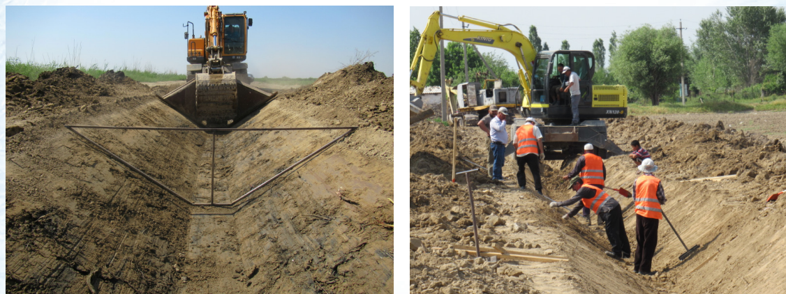
Фото-6. Строительно-монтажные работы на системах каналов К-11-1-2, К-13А (объект Мак-таарал-1, ПК-1» Туркестанской области)
