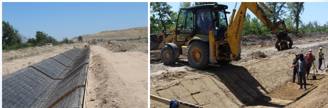
Фото-5. Строительно-монтажные работы на канала Глеуберды, Киши-Бурыл (объект «Капал» Жамбылской области)
