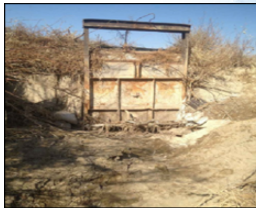
Фото-1. Разрушенный распределительный узел на оросительной сети
