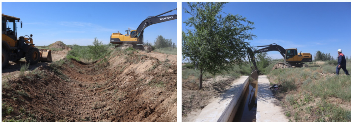
Фото-7. Строительно-монтажные работы на канале Р-26-2а-1 (Объект «Арысь-Туркестан» Туркестанской области)
