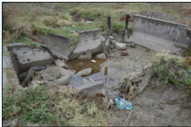
Фото-1. Разрушенный распределительный узел на оросительной сети
