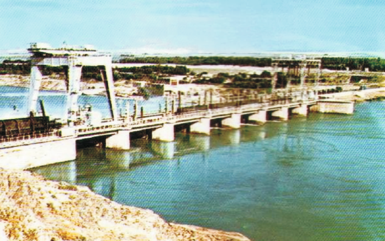
Фархадский гидроузел на реке Сырдарья (1960) The Farkhad Hydroscheme on the Syr Darya River
