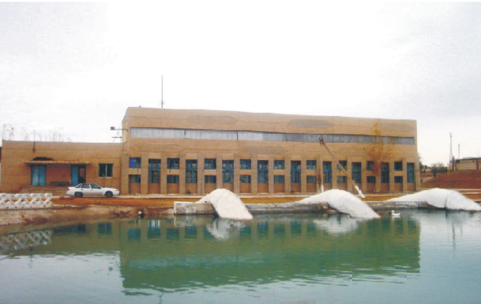
Насосная станция Канимех-2 The Kanimekh-II Pump Station
