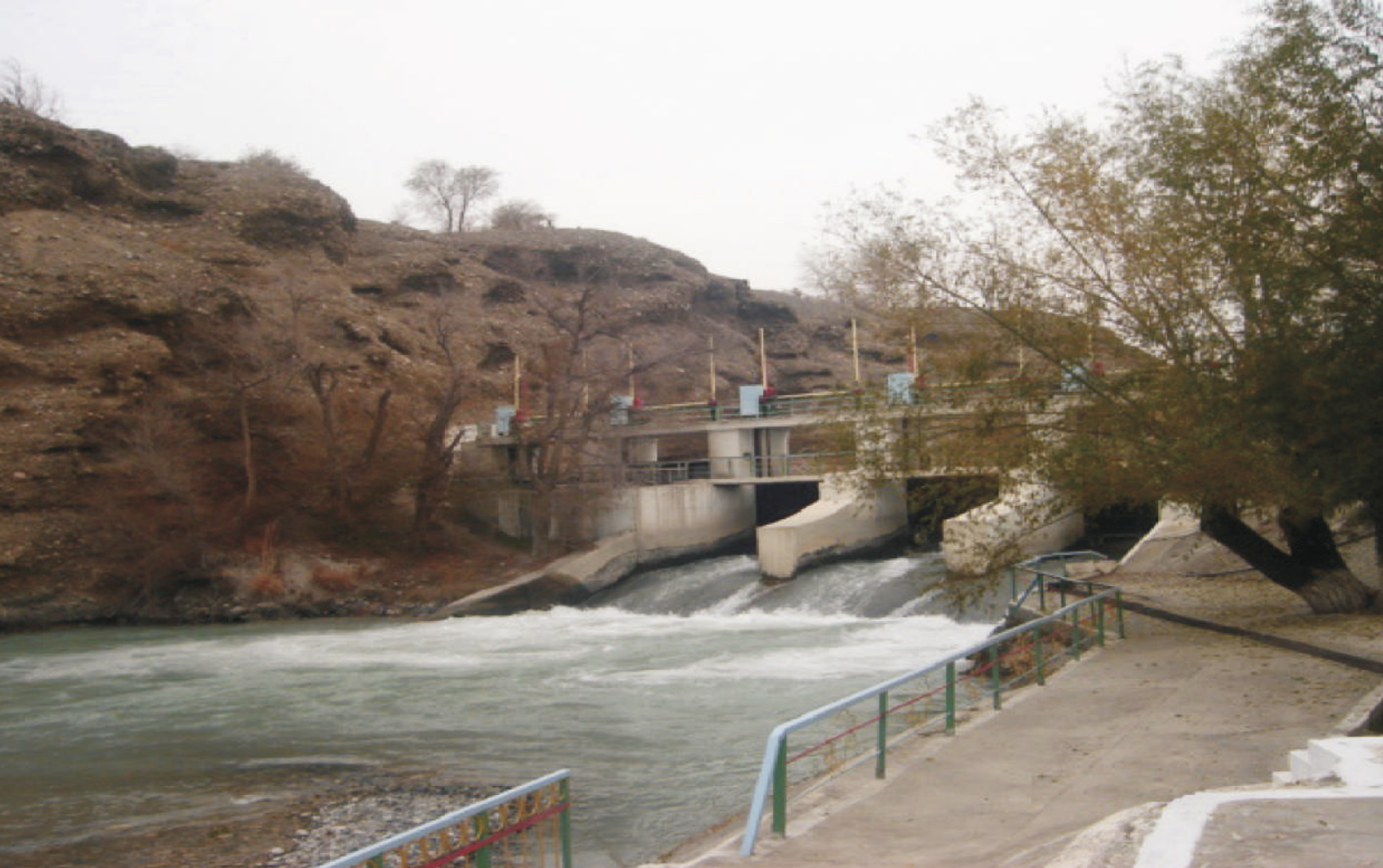
Головное сооружение на Правобережном канале БАК The Headwork of the Right-bank Canal from Great Andijan Canal
