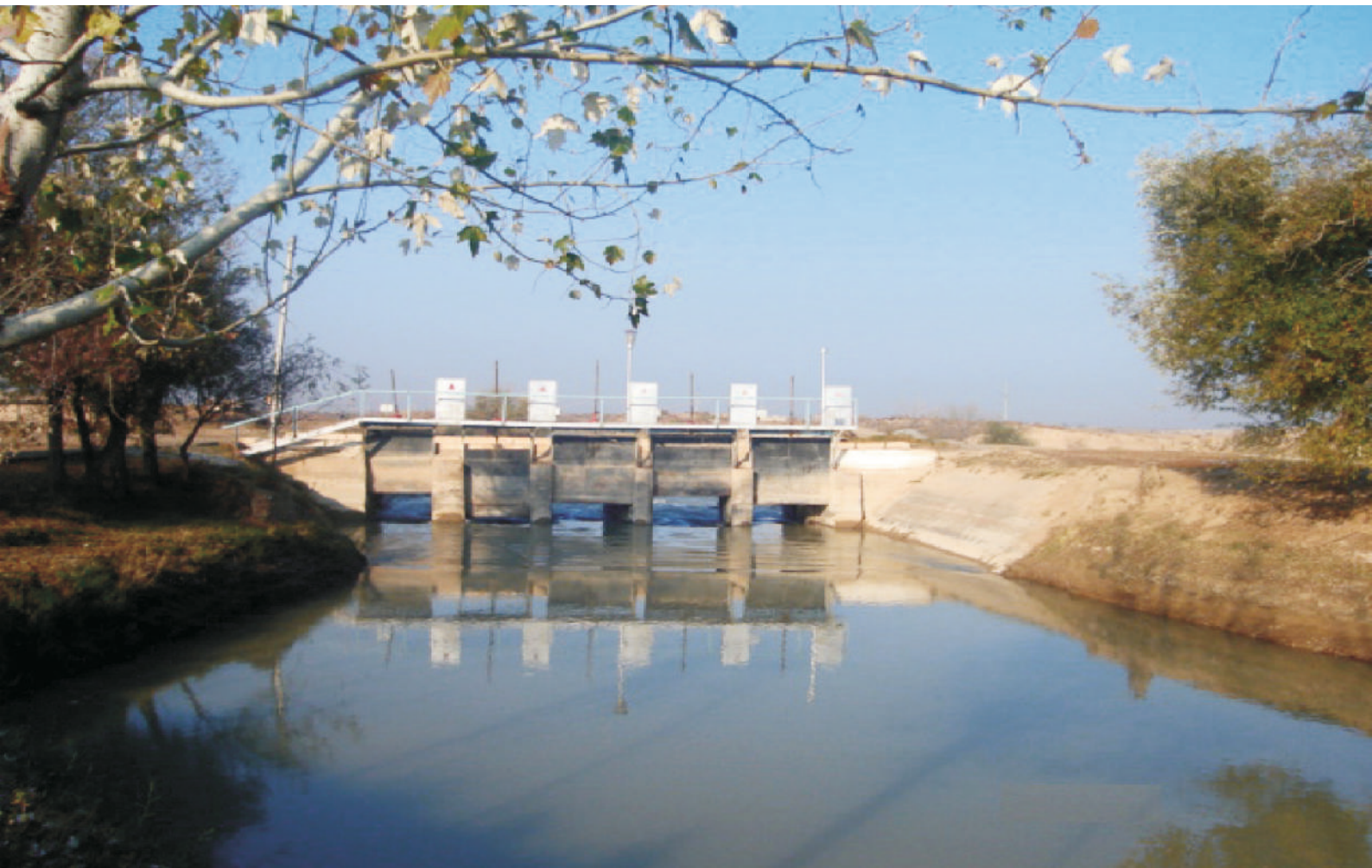
Головное сооружение на канале Обихаёт The Headworks on the Obikhaet Canal
