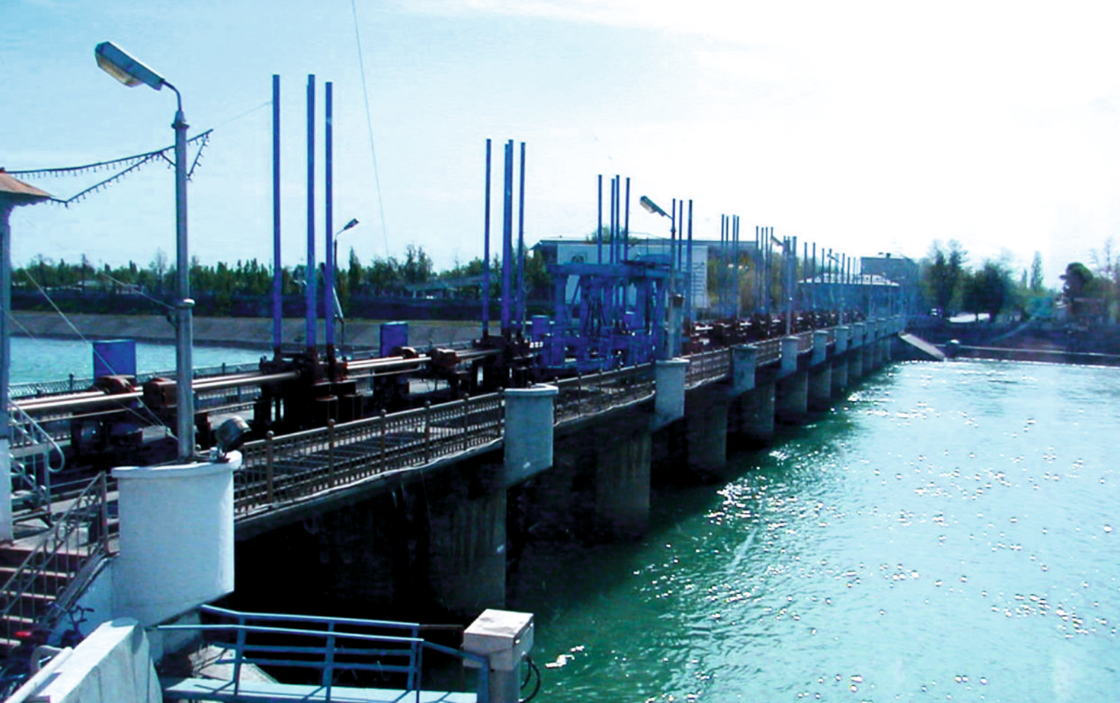
Учкурганский гидроузел (оснащенный SCADA) Uchkurgan Weir (equipped with SCADA)
