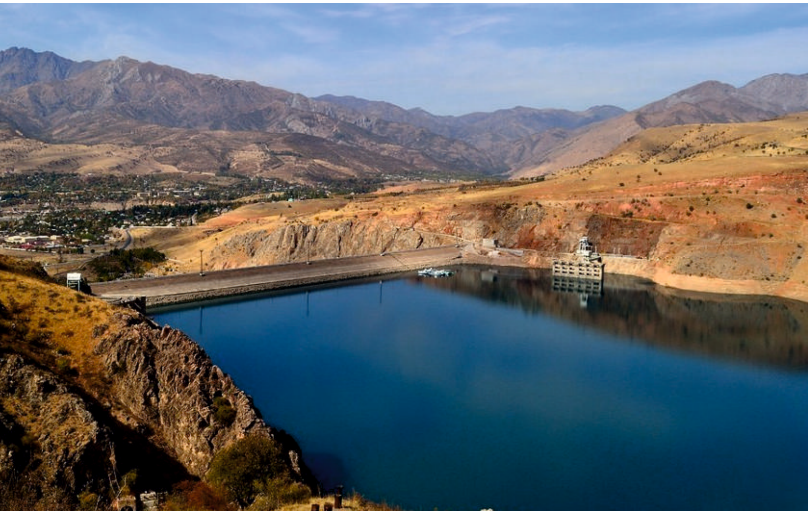
Чарвакское водохранилище - вид на плотину с верхнего бьефа The Charvak Reservoir - the Front View of the Dam
