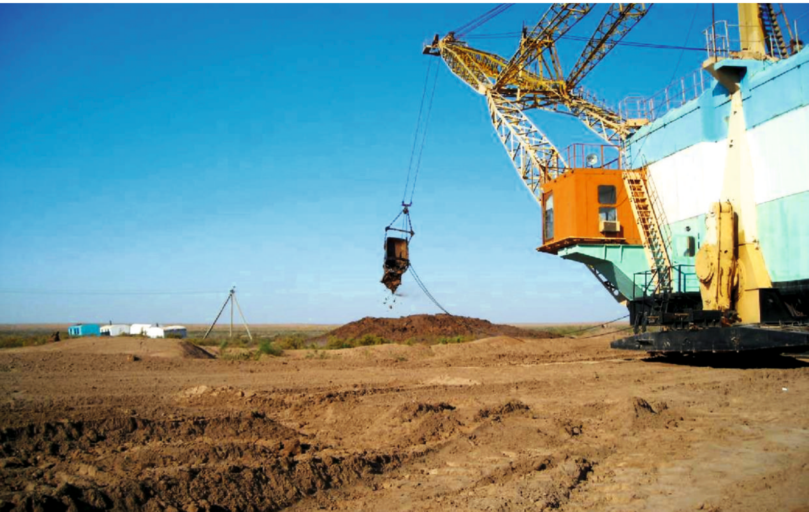
Работа шагающего экскаватора на строительстве Южного коллектора The Walking Excavator in Operation at the Construction Site of the South Karakalpakstan Main Collector-Drain
