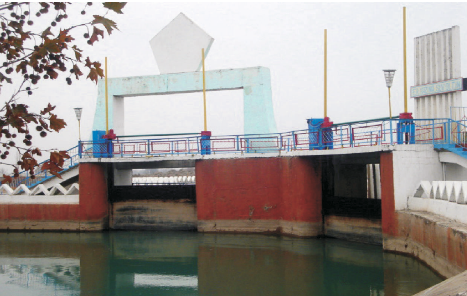
Гидроузел на Большом Андижанском канале Waterworks on the Big Andijan Canal
