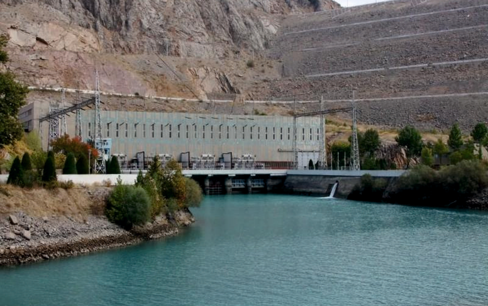
Здание ГЭС Чарвакского гидроузла на реке Чирчик The Powerhouse of the Charvak Hydroscheme on the Chirchik River
