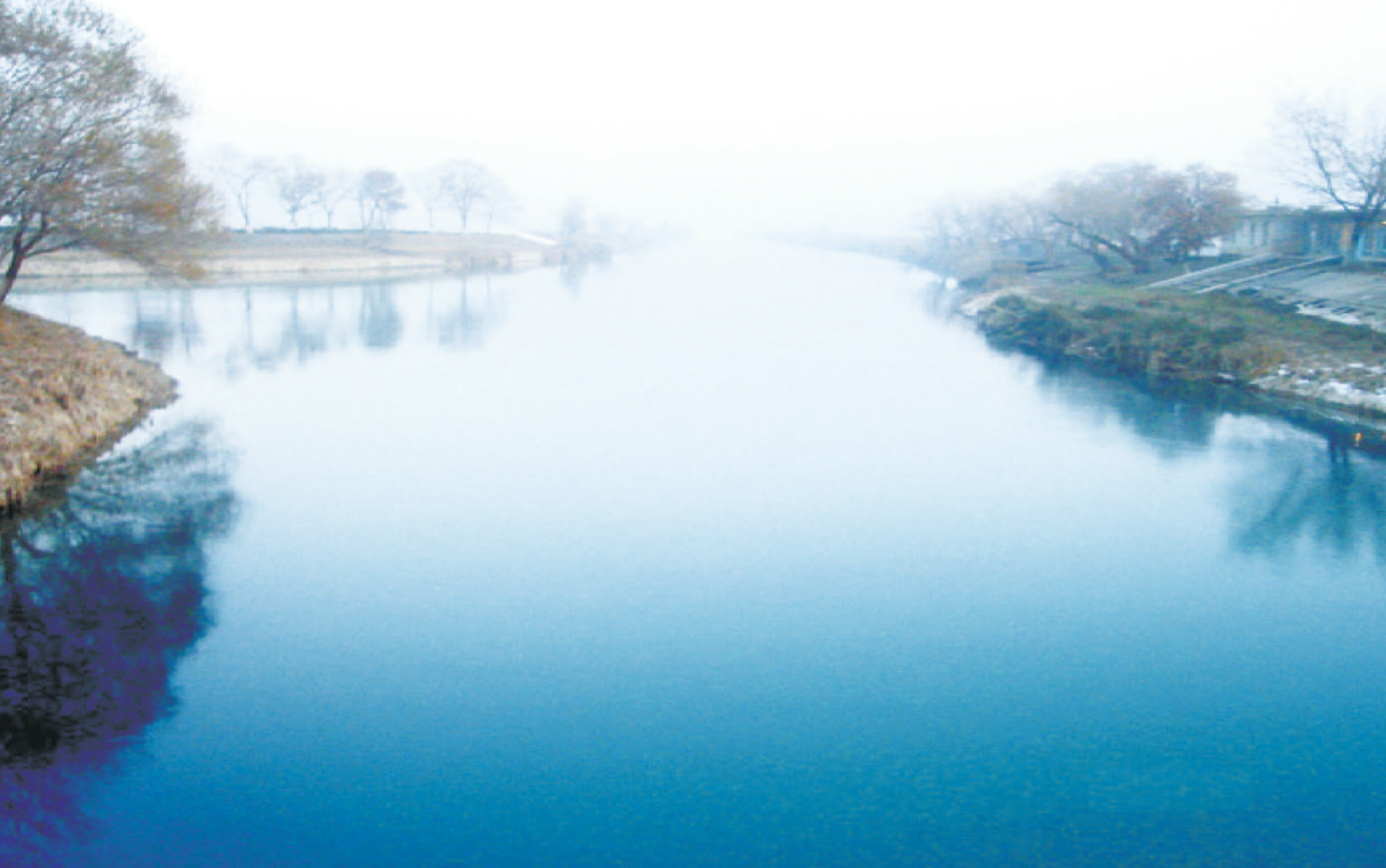
Южно-Голодностепский канал The South Golodnaya Steppe Canal
