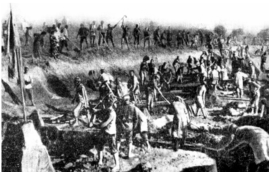
Рис. 3.10 Строительство Большого Ферганского канала [48]
