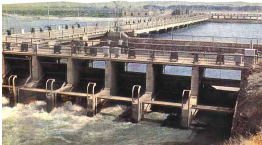
Рис. 3.6 б Вид на вновь построенную Рават-Ходжинскую железобетонную плотину на реке Зеравшан (Садыков, 1975 г.)
