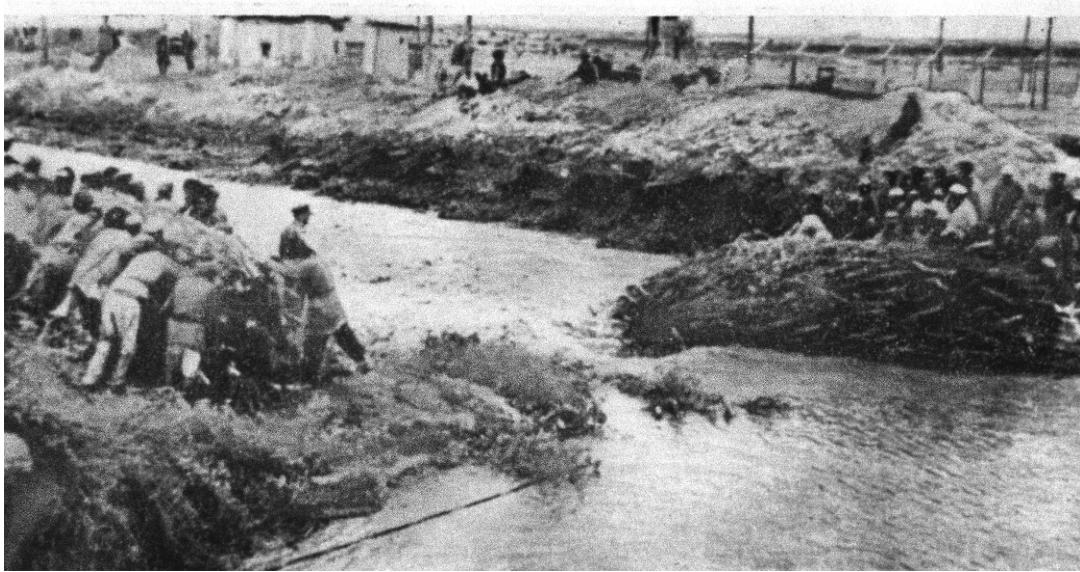
Рис. 2.14 Строительство карабуров (фотография Килдушева, заимствована из Ирригации Узбекистана, том 1, стр. 148)
