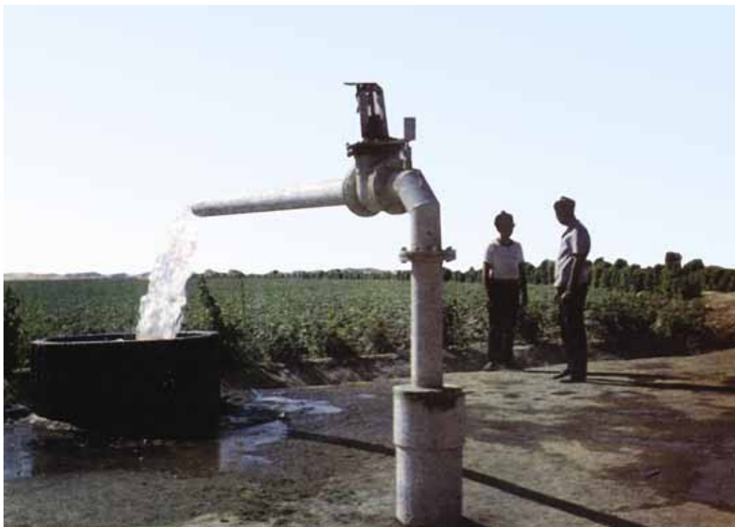
Рис. 3.20 Работа скважины вертикального дренажа (Духовный, 1981 г.)
