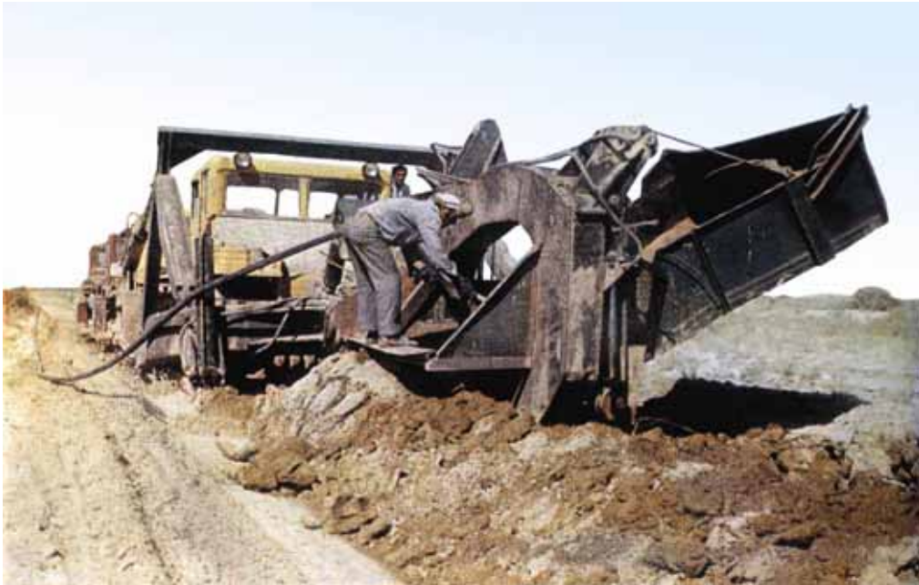
Рис.3.19 Строительство закрытой горизонтальной дрены бестраншейным дрено укладчиком (Духовный, 1981 г.)
