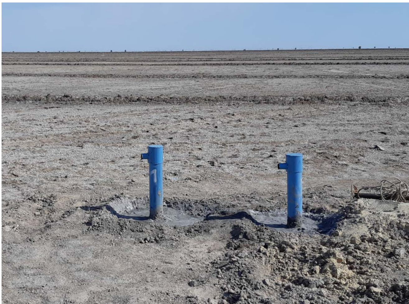
Рис. 36. Скважины наблюдения за уровнем грунтовых вод, ГКХ-1, установка июль 2019, по дороге на Возрождение
