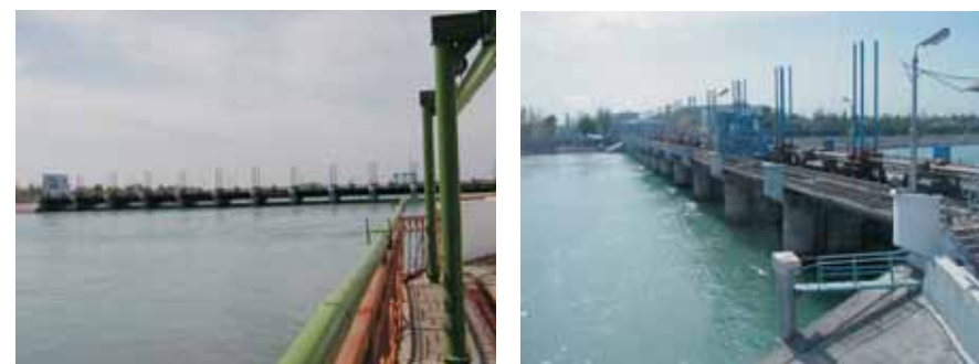
а) вид с верхнего бьефа; б) вид сбоку Рис. 1. Плотина Учкурганского гидроузла:
