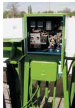
Рис. 2. Шкаф для местного управления затворами
