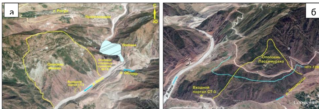
Рис.1. Оползнеопасные склоны вблизи плотины Рогунского гидроузла на р. Вахи: а) оползень №1 в нижнем бьефе (Атипичная зона); б) оползень №2 на правом борту сая Пасимурахо в верхнем бьефе водохранилища. Голубая линия - НПУ 1290 м.
