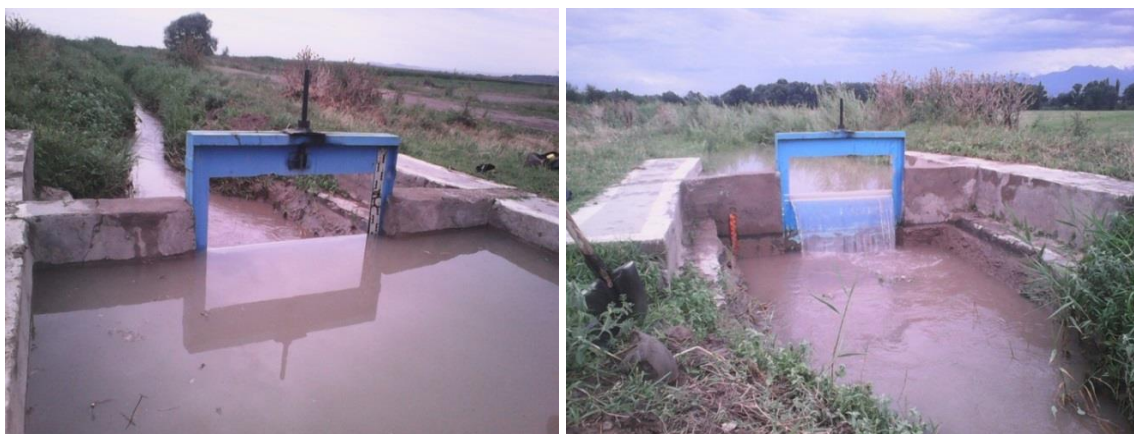
Рис 2. Водомер типа «Водослив-прямоугольный насадок» на Р-8 системы ЗБЧК (замер воды осуществляется водосливом). а – вид с верхнего бьефа; б – вид с нижнего бьефа.
