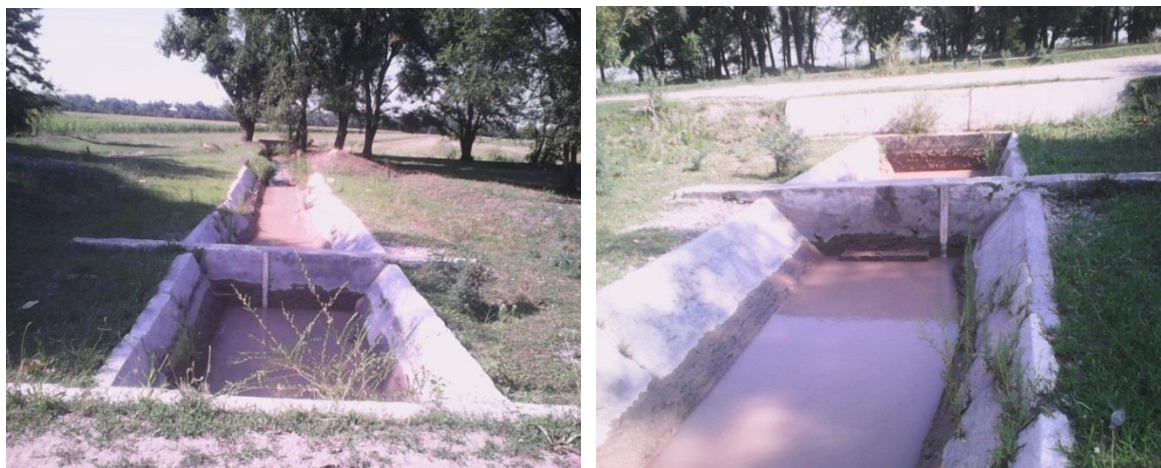
Рис 2. Водомерное сооружение типа «Прямоугольный насадок» на Р-2-6 ЗБЧК. а, б - соответственно виды с верхнего и нижнего бьефов.
