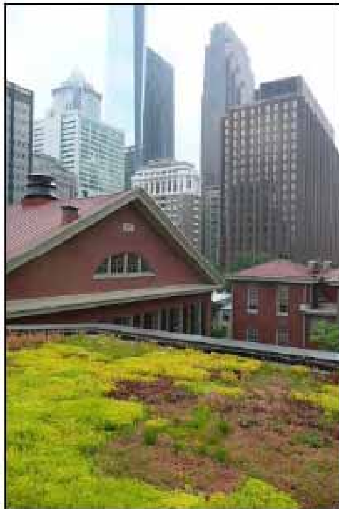
«Зеленая крыша», улавливающая дождевой сток, в Филадельфии (источник: Управление по охране окружающей среды)
