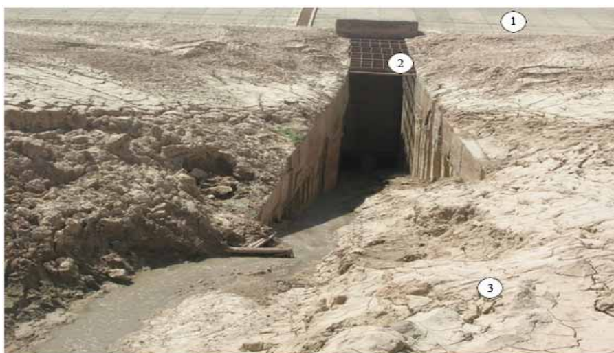
2 расм - Қорабоғ селсувомбори юқори бьефи сув чиқаргич иншооти зонасининг ҳозирги ҳолати 1- тўғон юқори қиялиги; 2-сув чиқазгич иншооти каллаги; 3-лойқа ётқизиқлари
