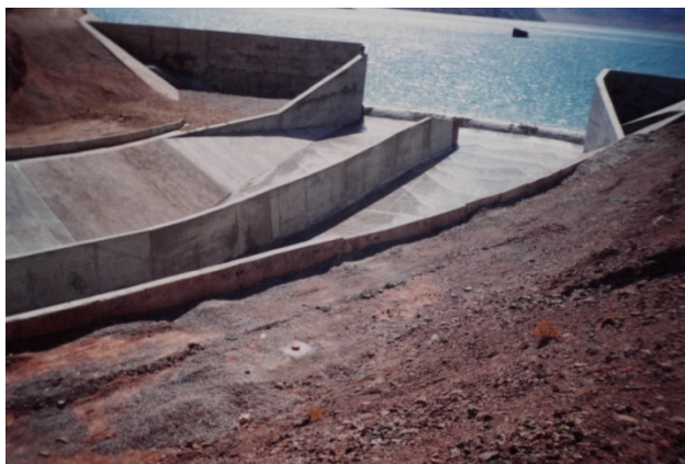
Рис. 7. Модель и построенная конструкция Орто-Токойского поверхностного катастрофического водосброса с устройством предупреждения волнообразования (А. свид. СССР №1821516; Н.П. Лавров).
