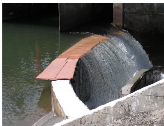
Рис. 5. Исследования и внедрение устройства рыбозащиты при водозаборе (патент КР №919, 2006; Н.П. Лавров, Н.В. Коржавин, Г.И. Логинов).
