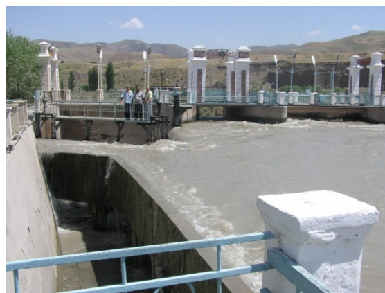
Рис. 3. Модель и натурный вариант бокового водозаборного сооружения на р. Куршаб (патент КР №586, 2003; Н.П. Лавров, А.И. Рохман, В.А. Биленко и др.).
