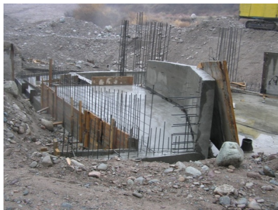
Рис. 4. Модель и строящееся водозаборное сооружение для деривационных ГЭС на р.Исык-Ата (патент КР №607, 2003; Н.П. Лавров, Г.И. Логинов, М.К. Торопов).
