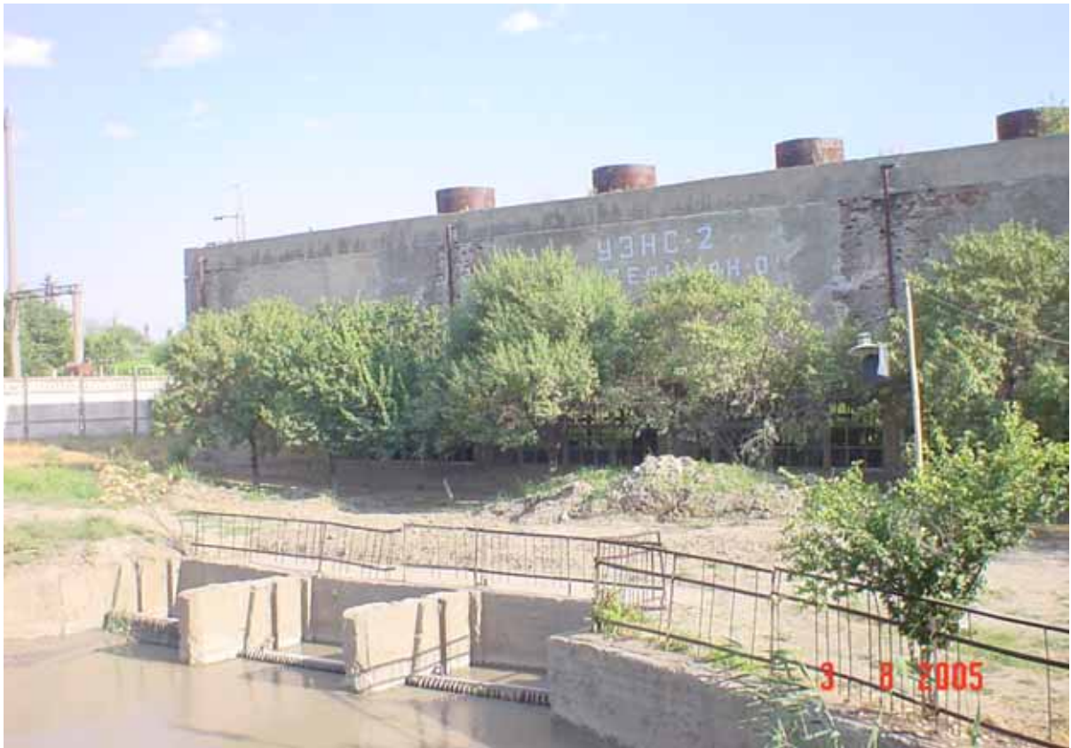
Рис. 4.5. Подводящий канал и общий вид насосной станции «Селькан – 0»
