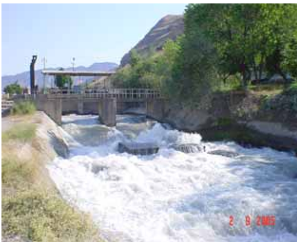
Рис.1.7. Вид с нижнего бьефа головного сооружения канала Ходжа-Бакирган
