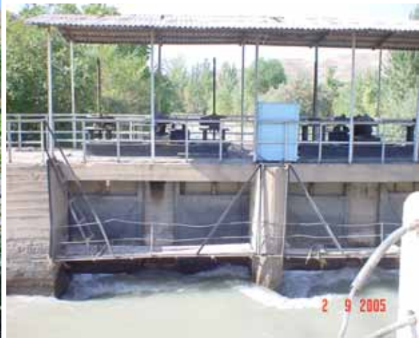
Рис.1.6. Сооружение на головном водозаборе канала Ходжа-Бакирган Q_{\phi} = 35,0 \text{ м}^3/\text{сек}
