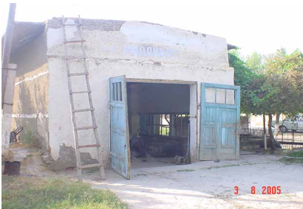
Рис. 4.12. Общий вид насосной станции «Маданият»
