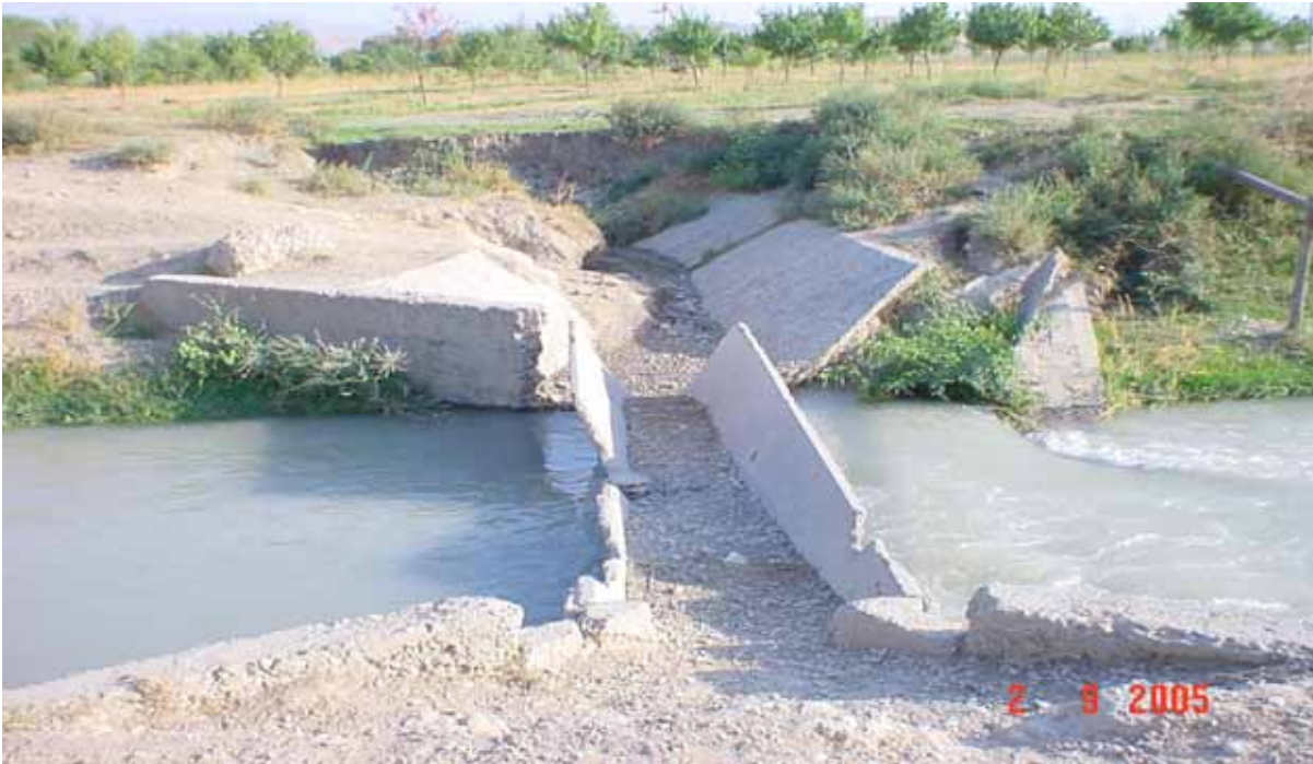
Рис.3.5. Лотковый сброс воды над каналом Ходжа-Бакирган.
