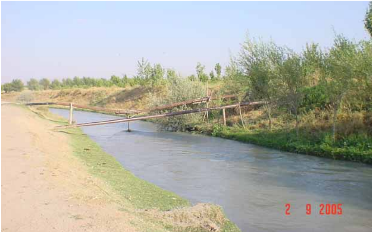
Рис.3.7. Трубчатый сброс над каналом
