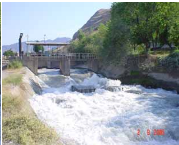
Рис.1.8. Перепад на канале Ходжа-Бакирган, ПК18
