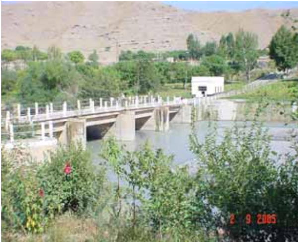
Рис.1.5. Плотина Ходжа-Бакирган на реке Ходжабакирган Q_{\max} = 300 \text{ м}^3/\text{сек}
