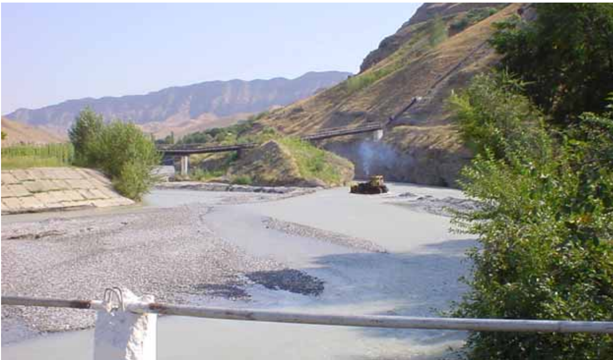
Рис 3.10. Подготовительные работы перед промывкой емкости верхнего бьефа
