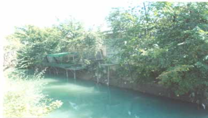
Устройство туалетов в ВОЗ Араван-Акбуринского канала, г.Ош.
