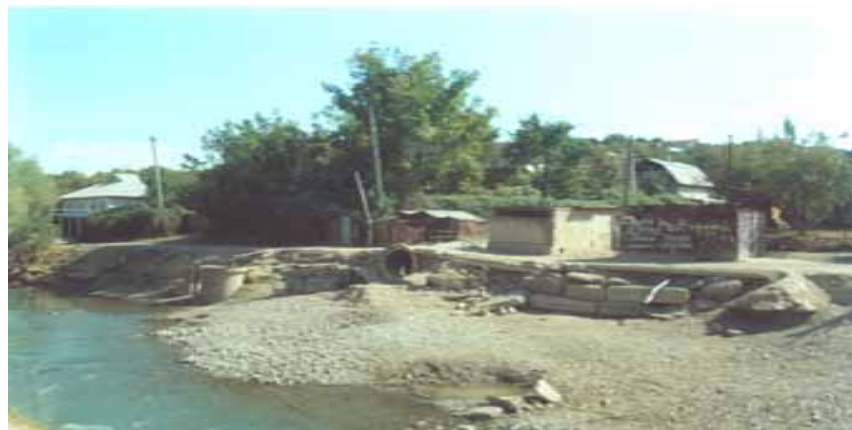
Устройство насосной станции для полива дачных участков на Араван-Акбуринском канале /площадка для сбора мусора и подмыв бетонного покрытия/
