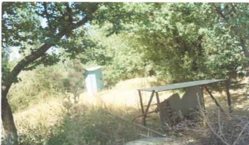
Незаконные хозяйственные постройки и навесы на Араван-Акбуринском канале /микрорайон «Туран» г. Ош/.
