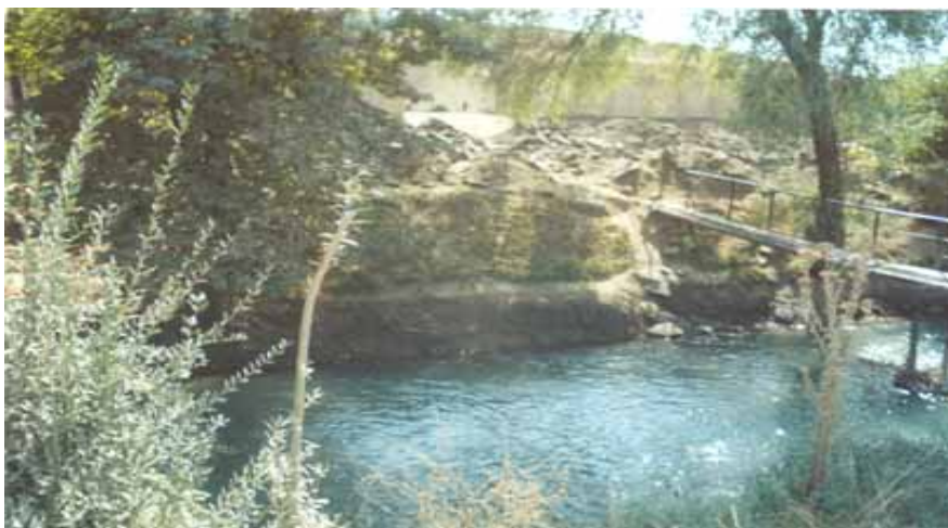
Складирование дорожного покрытия в ВОЗ Араван-Акбуринского канала в районе ДЭУ 21 г. Ош.
