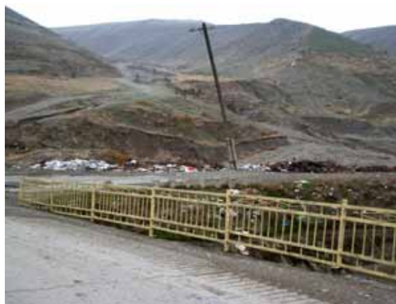
Рис.9. Несанкционированная свалка мусора на водоохранной зоне на ПК-676+42 (г/у «Толмозор»).
