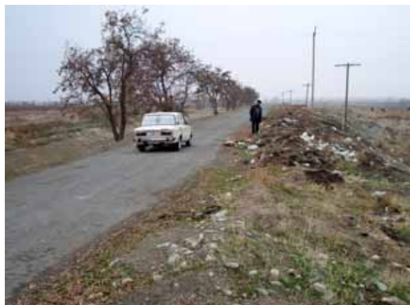
Рис.11. Несанкционированная свалка мусора на водоохранной зоне канала.
