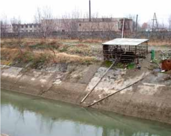
Рис. 4. Насосная станция на ПК-760+00 (г/у «Акбаробод»)
