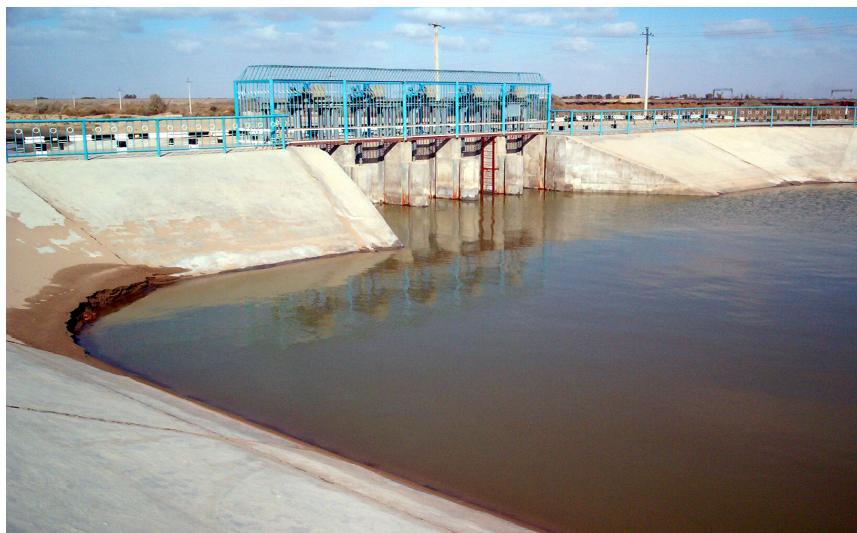
Гидроузел на реке Сырдарья. Hydropost on the Syr Darya river.
