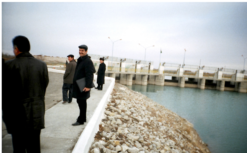
Узел №1 гидросооружения Туркмендарья. Post №1 of Turkmenaryana Hydrotechnic Facility.
