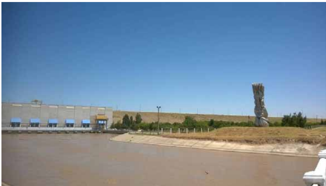
Седьмая насосная станция на Каршинском магистральном канале. Видна дамба Талимарджанского водохранилища
