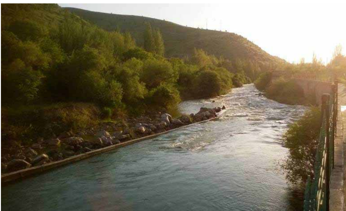
Отводящий канал в нижнем бьефе Гиссаркского гидроузла
