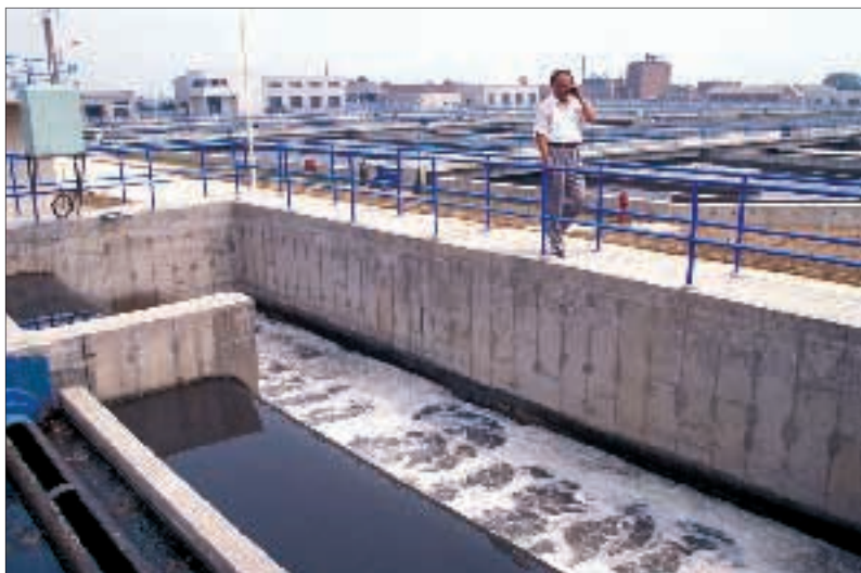
Осмотр станции «Dongjiao» по очистке сточных вод города Таншаня. Китайская Народная Республика
