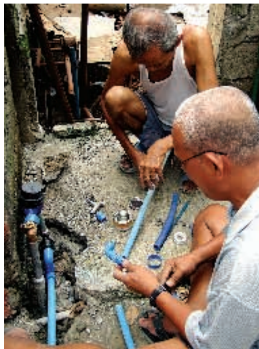
Монтаж трубопроводов, оборудованных счетчиками, в районе Алитаптар, Манила
