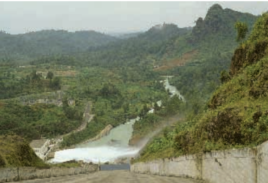
Плотина для производства гидроэлектроэнергии, Индонезия
