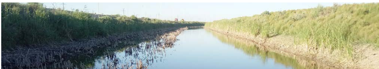
Фото 43: Точка 43. Мост через канал Муйнак.
