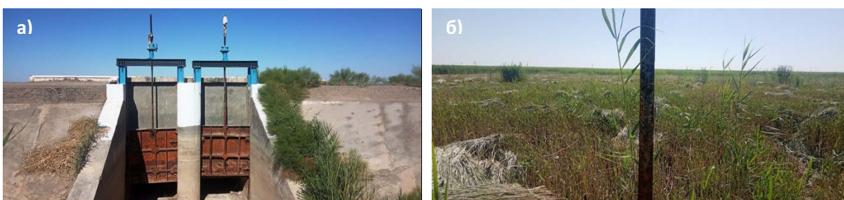
Фото 51: Точка 51. Северо-западная часть вдхр. Муйнакского залива: Водовыпускное сооружение (а) и рабочий гидропост внутри водоема (б).
