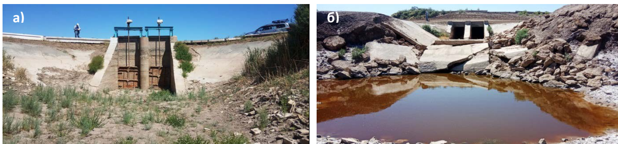
Фото 54: Точка 54. Водовыпускное сооружение со стороны верхнего (а) и нижнего бьефа (б).
