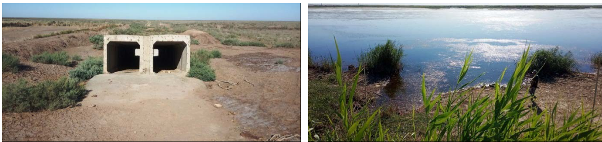
Фото 49: Точка 49. Северо-западная часть вдхр. Муйнакского залива: незавершенное строительство водовыпускного сооружения (а) и водоем, покрытый в некоторых местах растущими тростниками и водяными растениями (б).
