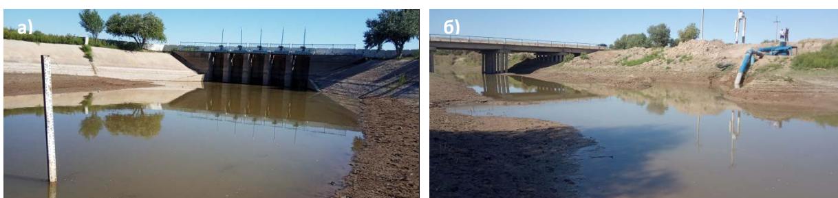
Фото 34: Точка 34. Головное сооружение канала Муйнак (а), водозабор насосом для полива риса (б).
