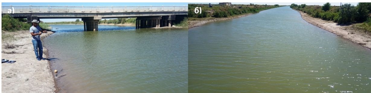
Фото 69: Точка 69. Мост (а) на коллекторе КС-1 (б).
