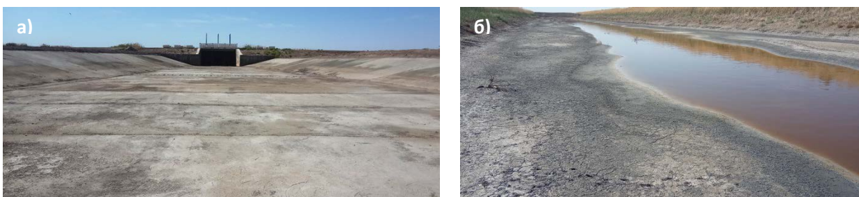
Фото 5: Точка 5. Водовыпускное сооружение на взрывном русле коллектора ККС.
