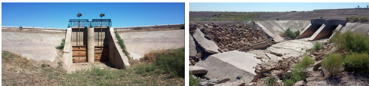
Фото 52: Точка 52. Водовыпускное сооружение со стороны верхнего (а) и нижнего бьефа (б).
